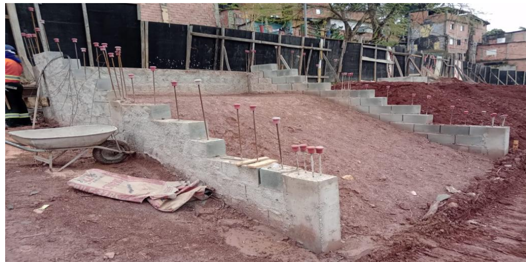
Trecho 2: Construção da escala de ligação entre viela e rua
