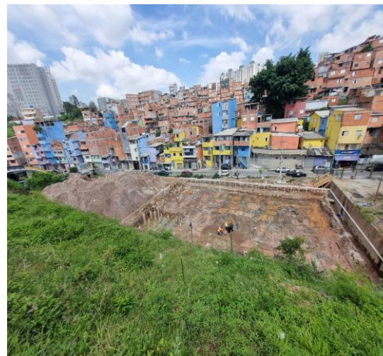
Cond. J – Arrasamento de estacass da fundação
