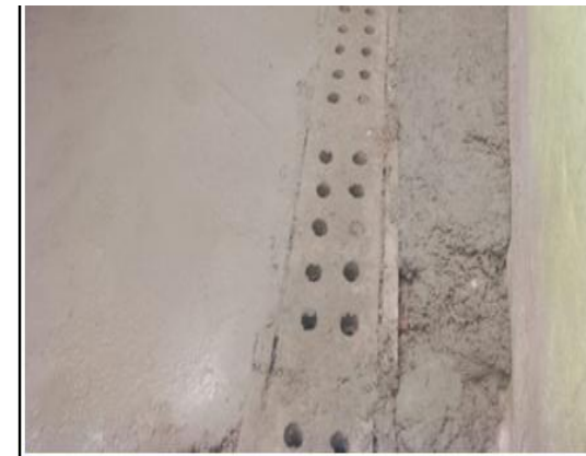
Instalação de grelhas de concreto
