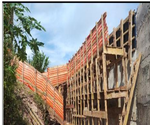
Núcleo Lirios: Execução de forma muro extrutural 2B.
