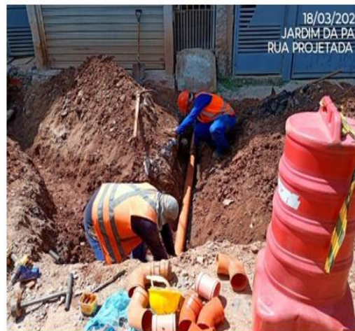
Ligação dos ramais residenciais de esgoto
