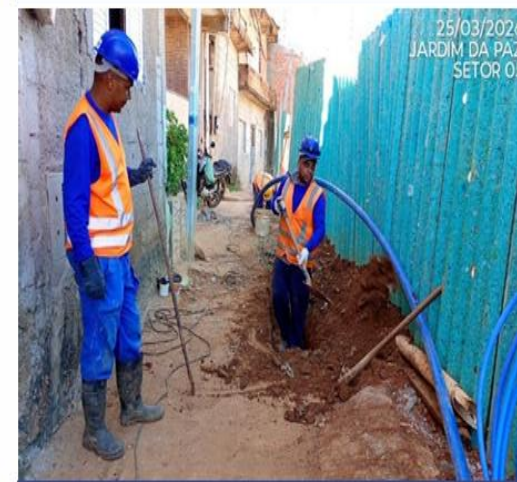
Execução de ligação residencial de água potável
