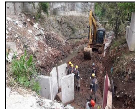
Núcleo Sálvia: Execução de canalização em aduelas.
