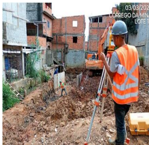
Conferência de cota para assentamento de aduela
