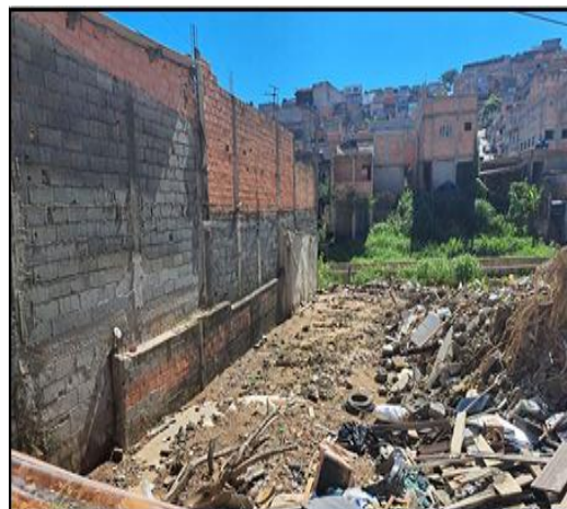
Rua Vitória do Vale - Demolições
