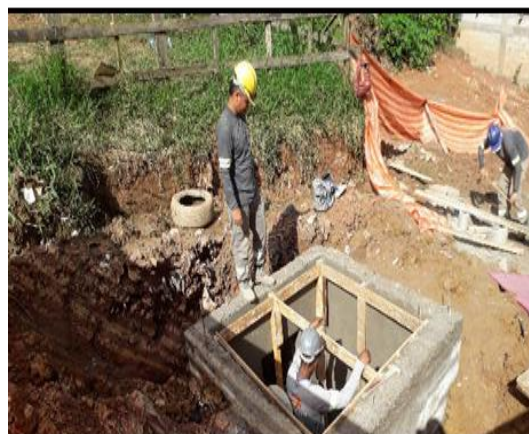
Núcleo Lirios: Execução de caixa de drenagem da rua Gladiolos.
