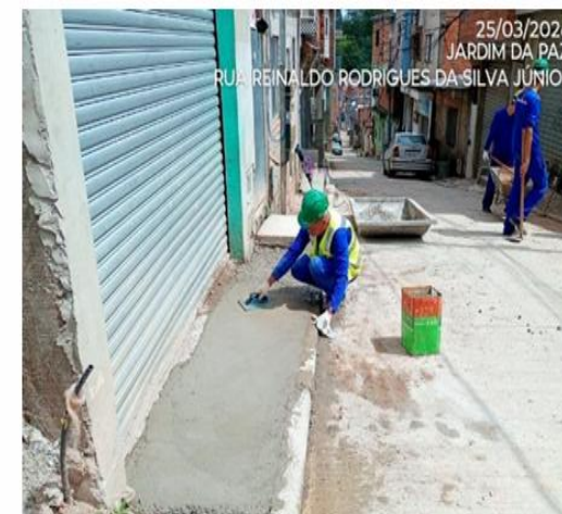
Concretagem do passeio
