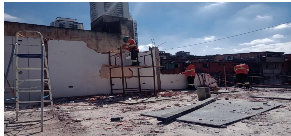
Trecho 2: Demolição de moradia e comércio
