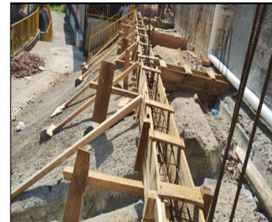
Núcleo São Jorge: Execução de formas e ferregens de acesso a moradias
