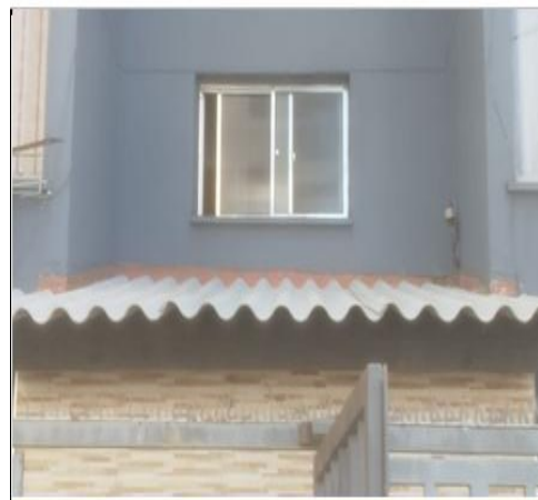
Novo telhado na entrada dos halls
