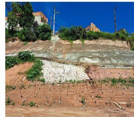
Rua Vitória do Vale - Solo Grampeado
