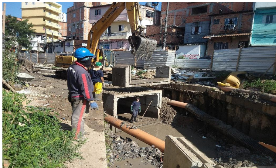
Instalação das aduelas de concreto
