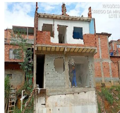
Demolição de moradia
