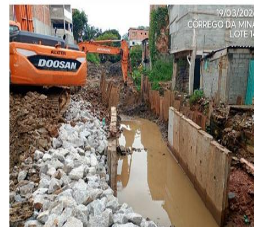
Remoção de solo mole para assentamento das aduelas
