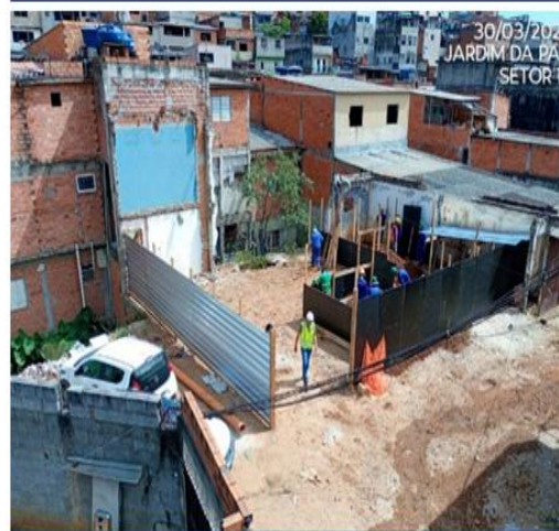
Montagem de canteiro de obras
