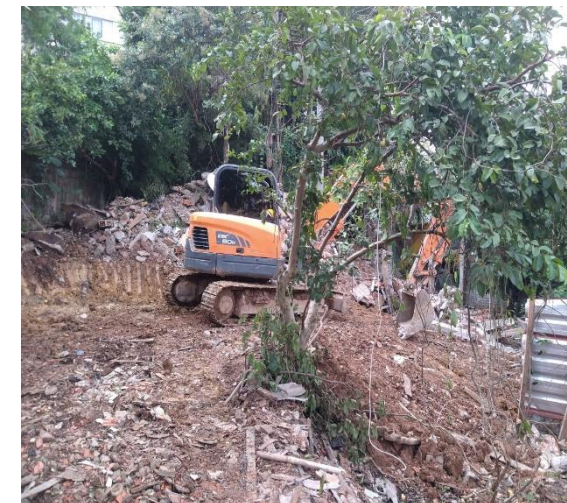
Cond. K – Remoção de entulho
