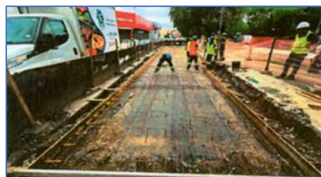
ARMAÇÃO DE PAVIMENTO RÍGIDO
