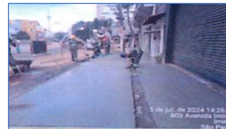
CONCRETAGEM DE PASSEIO E SARJETA E:271+00 até E 272+15 LD
