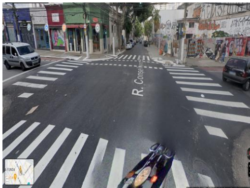
Foto antes da Intervenção. Dez/2023
