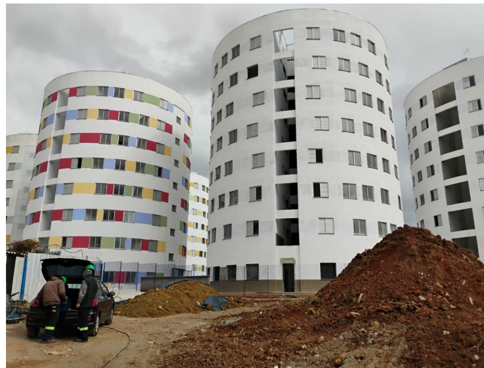
EXECUÇÃO DE PINTURA EXTERNA
