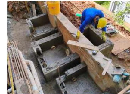
Execução das caixas de esgoto
