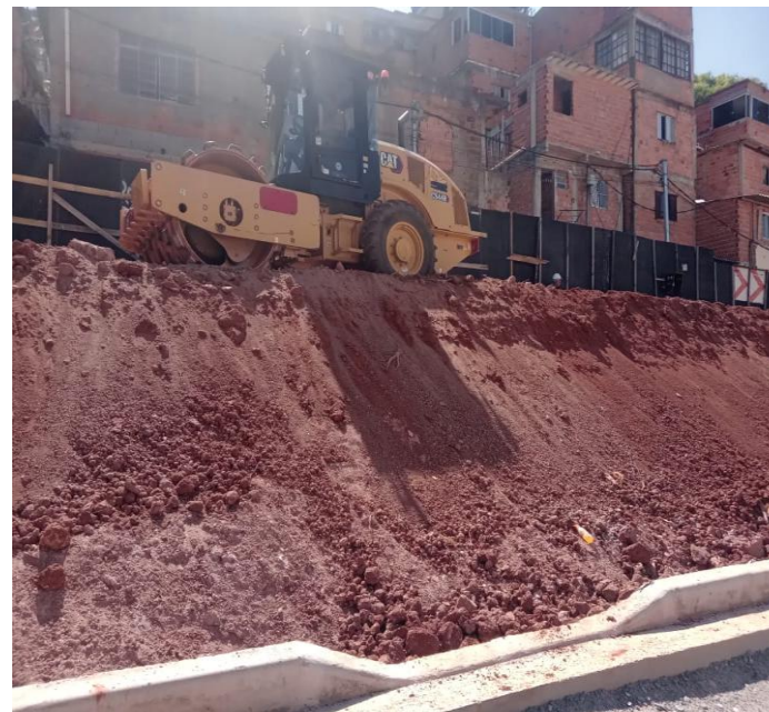
COMPACTAÇÃO DE TALUDE
