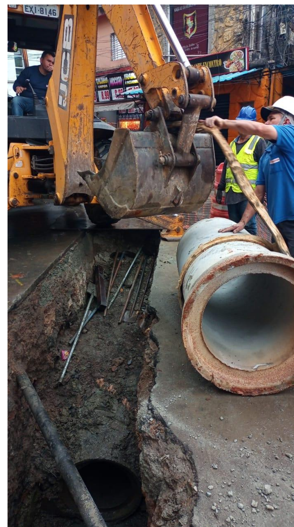
Lidiane – Sampaio Corrêa – Instalação de Aduela
