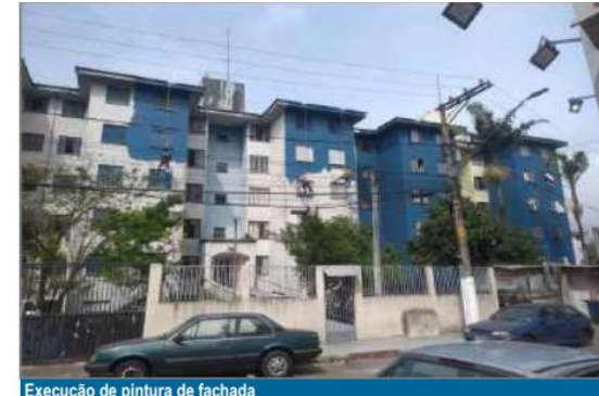
Execução de pintura de fachada
