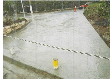
CONCRETO RECÉM-LANÇADO (CALÇADAS)
