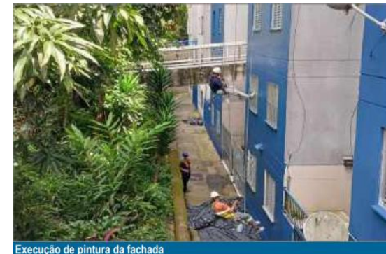
Execução de pintura da fachada
