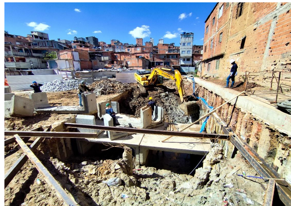
Instalação das aduelas de concreto
