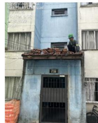
FOTO 09 - TELHADO E FACHADA HALL DE ENTRADA
