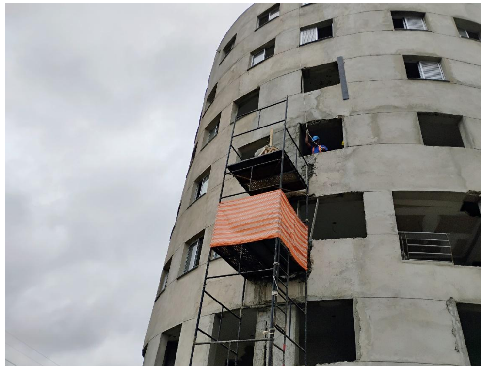
Foto: Revestimento da Fachada
