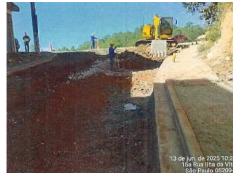
ABERTURA DE CAIXA PARA PAVIMENTAÇÃO
