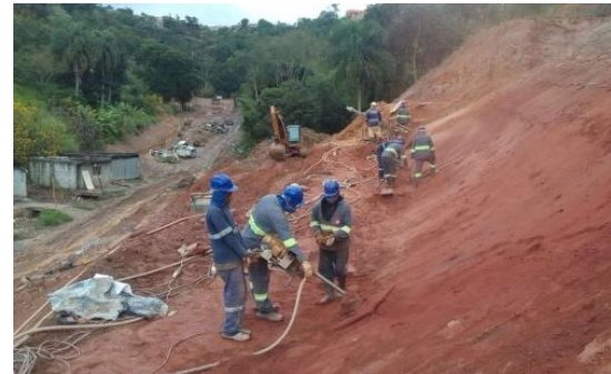
PERFURAÇÃO DO TALUDE
