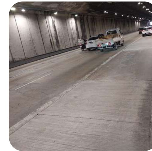
Túnel do Anhangabaú - faixas 4 e 5, ambos os sentidos (concluído)
