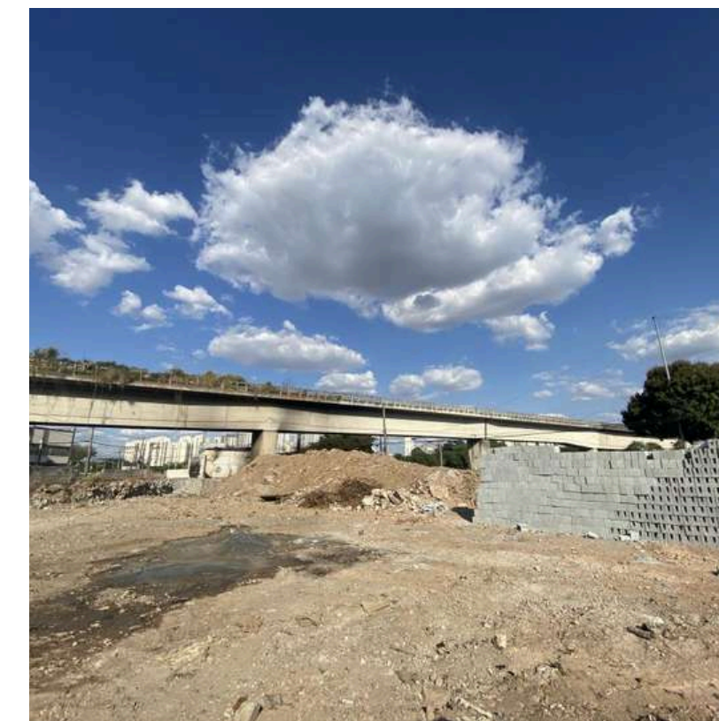
Foto em execução
