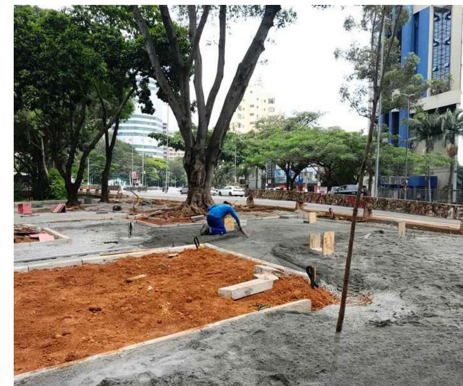
Foto em execução
