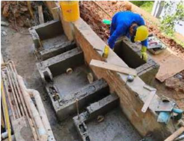
Execução das caixas de esgoto
