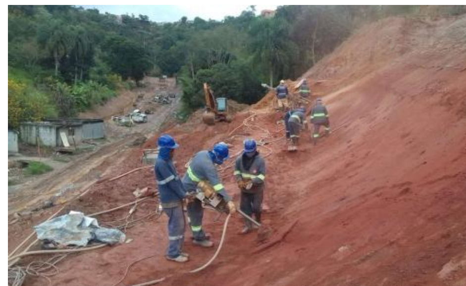
PERFURAÇÃO DO TALUDE
