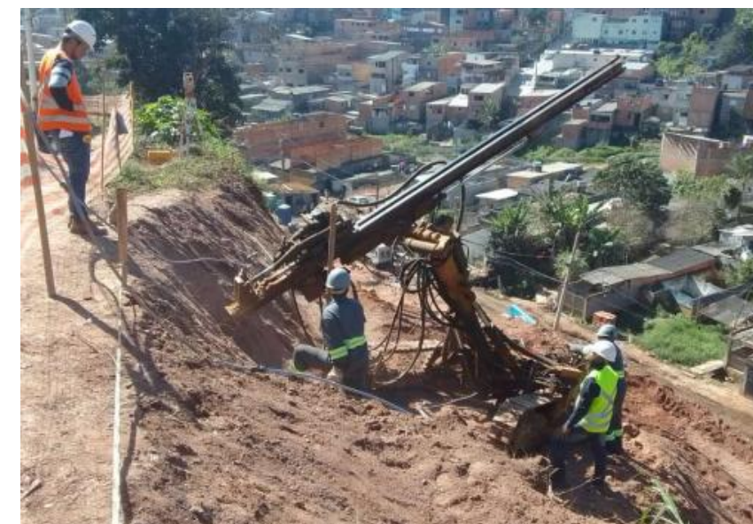
PERFURAÇÃO DO TALUDE
