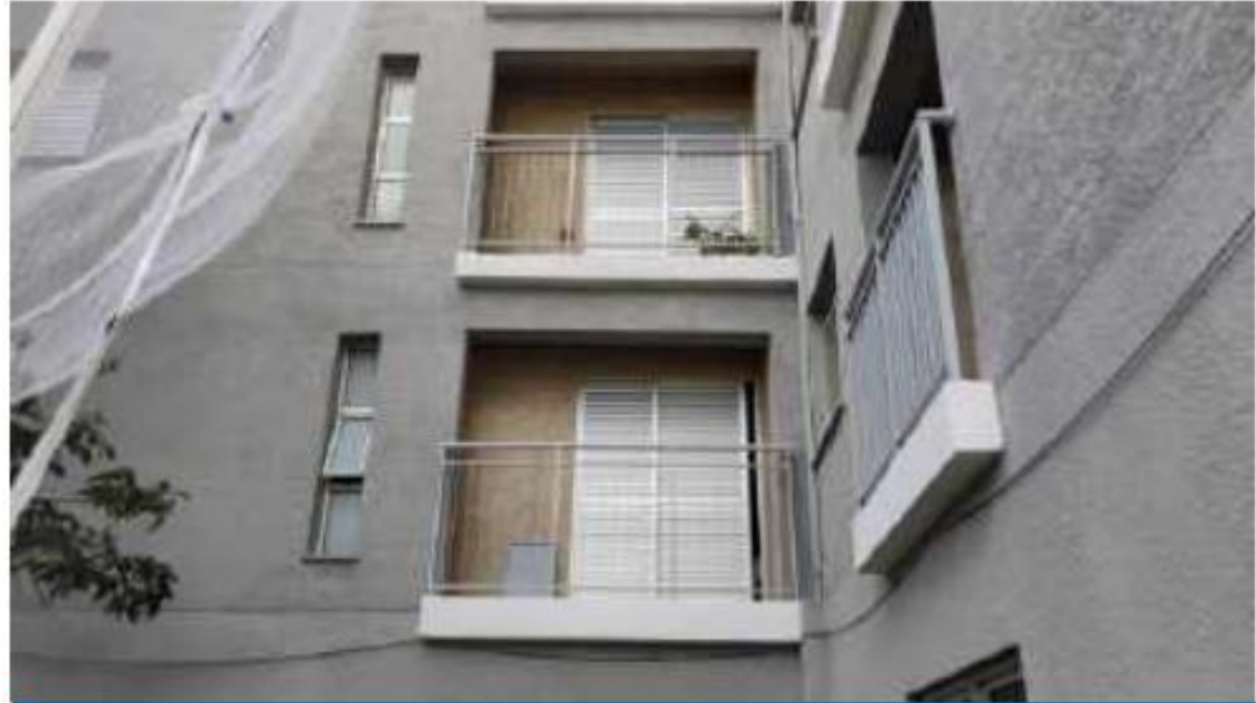
Pintura de guarda corpo
