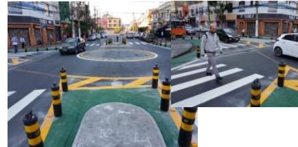
Implantada minirrotação para redução da velocidade e ordenamento veicular, melhorando a segurança dos pedestres
