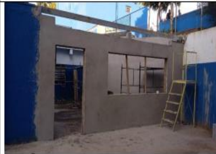
FOTO 72 – CHAPISCO, EMBOÇO E REBOCO SALA DE BOXE
