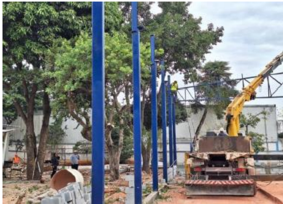
ESTRUTURA METÁLICA - COBERTURA PISCINA - PILARES
