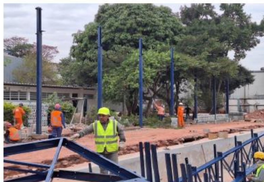
ESTRUTURA METÁLICA - COBERTURA PISCINA - PILARES
