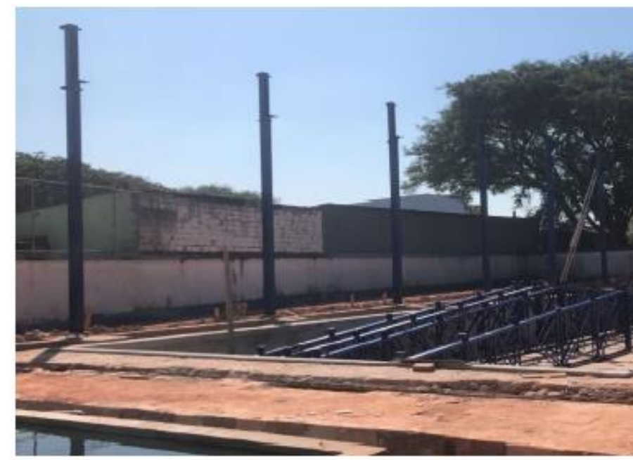
ESTRUTURA METÁLICA - COBERTURA PISCINA - PILARES
