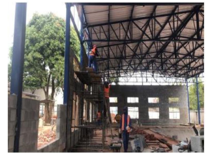
ALVENARIA DE FECHAMENTO - PISCINA
