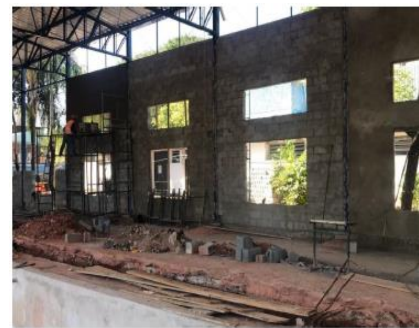
ALVENARIA DE FECHAMENTO - PISCINA
