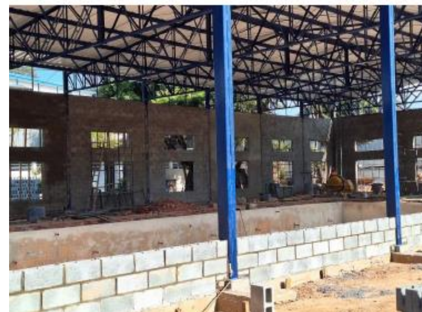
ALVENARIA DE FECHAMENTO - PISCINA
