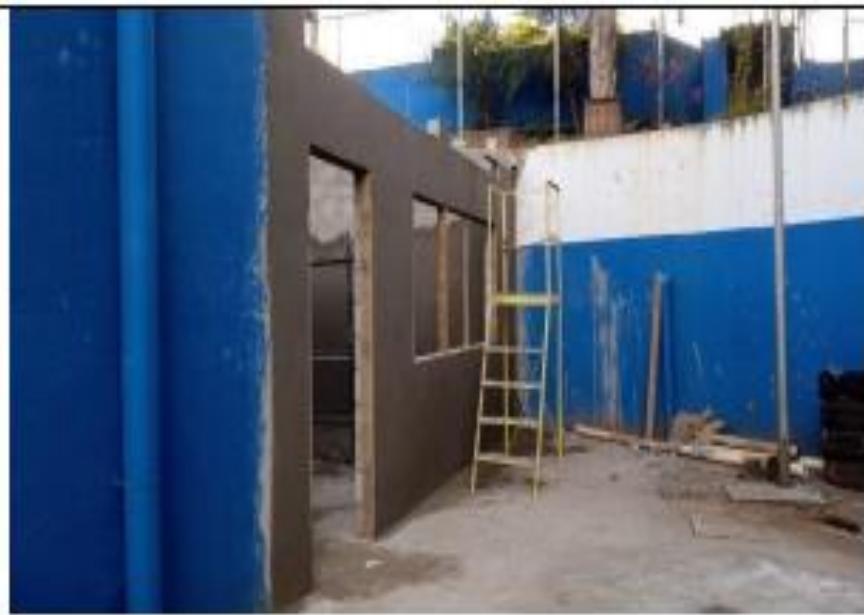
FOTO 71 – CHAPISCO, EMBOÇO E REBOCO SALA DE BOXE
