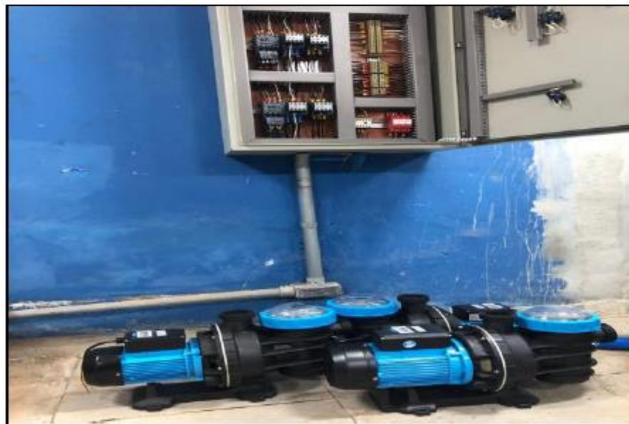
CONJUNTO MOTOR-BOMBA 240M3/H, 20MCA, 20CV,
