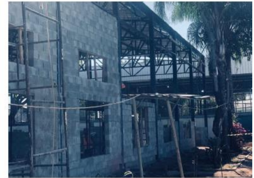
ALVENARIA DE FECHAMENTO - PISCINA
