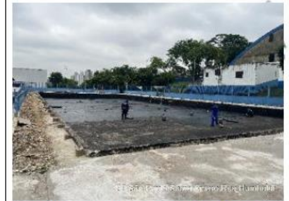
PISCINA – IMPERMEABILIZAÇÃO MANTA ASFALTICA
