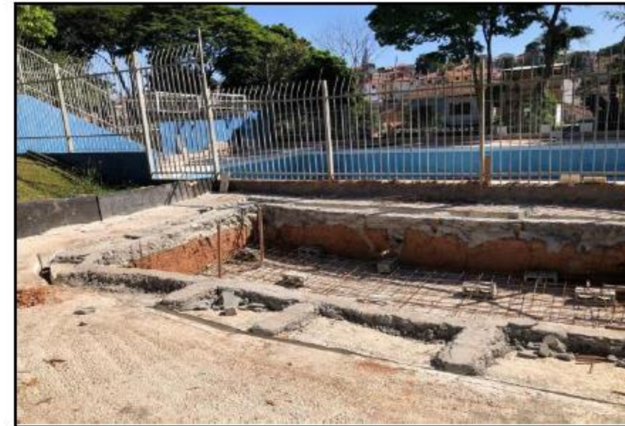
ARMADURA DE AÇO
