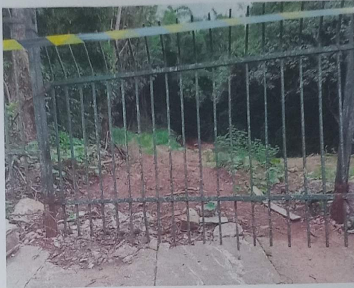
Foto 13 – Gradil a ser removido
