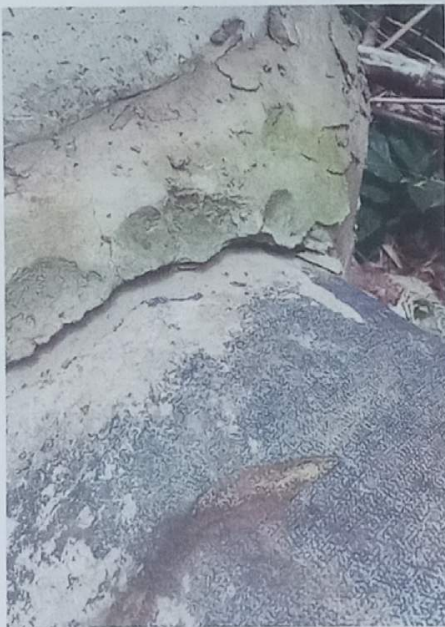
Fotos 11 e 12 – Fissuras no concreto ao longo da tubulação
