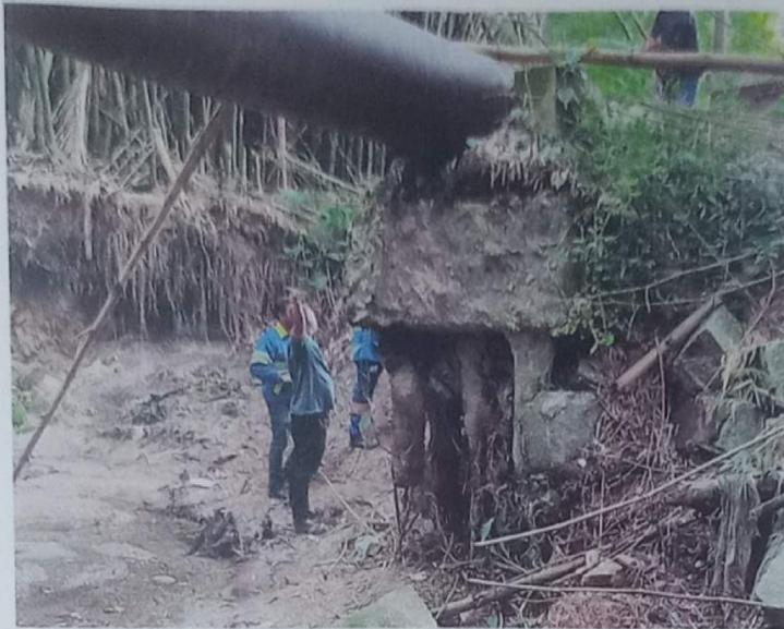
Foto 8 – Visão da tubulação margem direita
