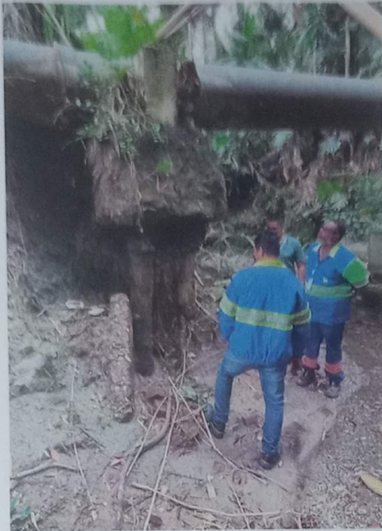
Foto 4 – Base de sustentação margem direita
