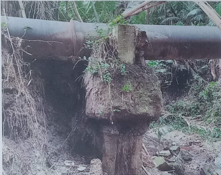
Foto 9 – Base de sustentação margem direita
