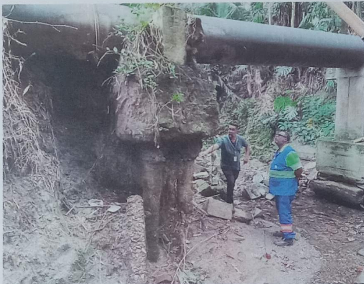
Foto 3 - Base de sustentação margem direita
