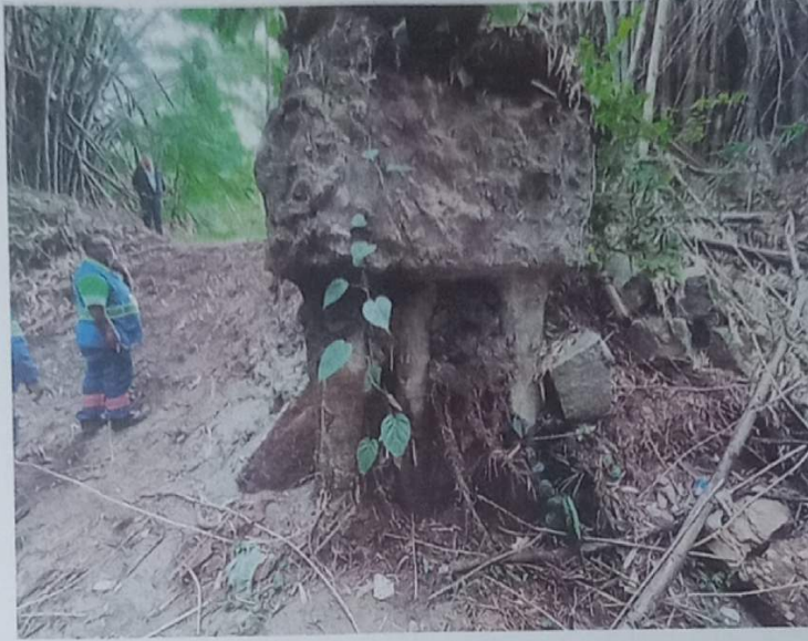
Foto 6 – Visão da base sustentação margem direita
