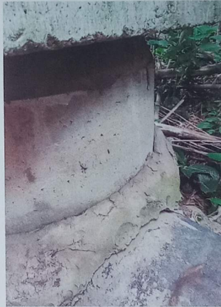
Fotos 11 e 12 – Fissuras no concreto ao longo da tubulação
