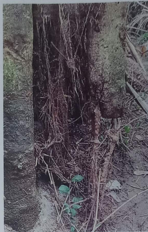
Foto 2 - Base sustentação margem direita
