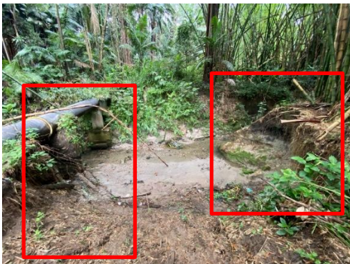
Imagem 5: Visão geral da tubulação de esgoto e ponta do talude a ser cortado.
