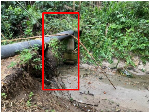
Imagem 3: Tubulação de esgoto será voltada ao seu alinhamento original e receberá um novo apoio para sustentação em aço realizado pela equipe da Sabesp.
