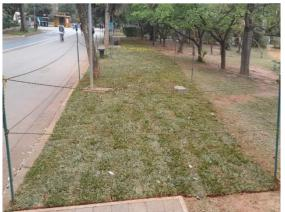
Figura 66: Áreas de descompactação de solo exposto e plantio de grama.
