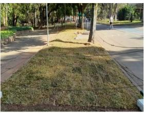
Figura 64: Áreas de descompactação de solo exposto e plantio de grama.
