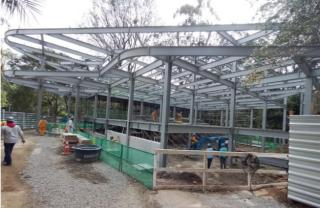
Figura 147: execução estrutura metálica e laje.
