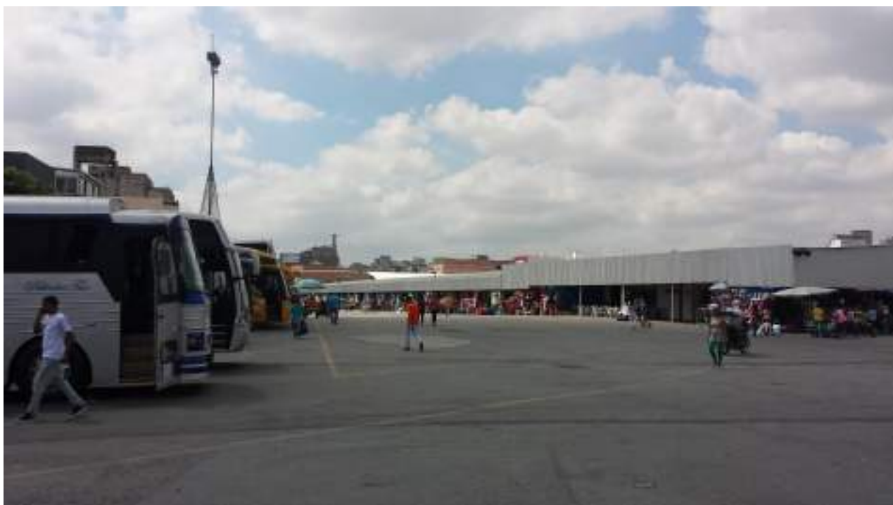
Foto 06 – Vista das Instalações Metálicas – Loja
