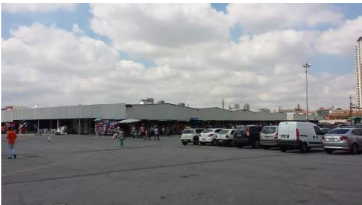
Foto 05 – Vista das Instalações Metálicas – Lojas
