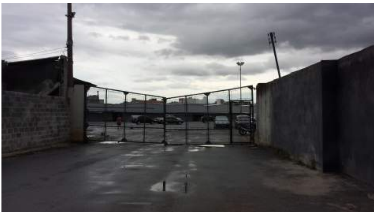
Foto 22 – Acesso da Av. do Estado – Vista Externa Acesso de Saída de Veículos
