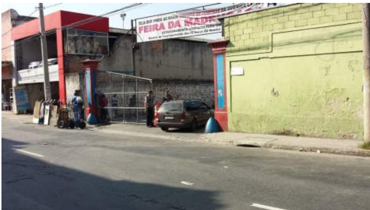
Foto 01 – Acesso da Rua São Caetano – Vista Externa
