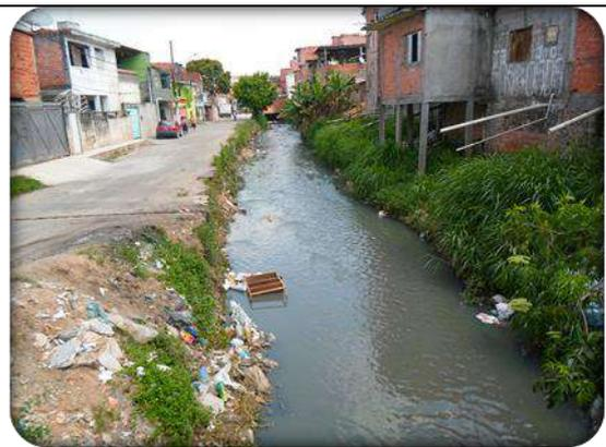
**Foto 11.3-2** – Margem do Afluente do Córrego Pirajuçara suscetível à pequeno escorregamento.
