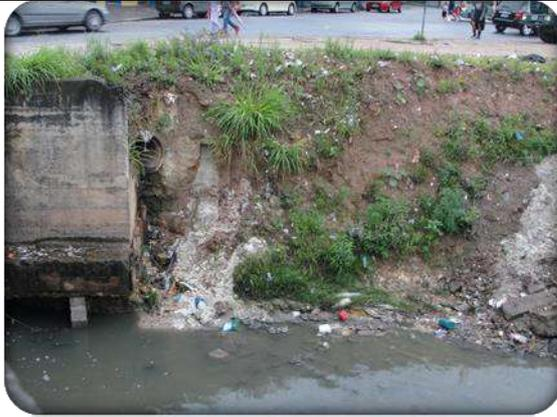
**Foto 11.3-3** - Margem do Afluente do Córrego Pirajuçara suscetível à pequenos escorregamentos.
