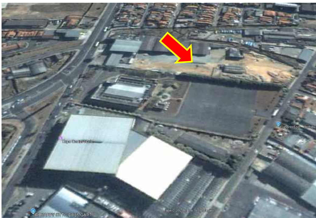
Figura 49 – Imagem de 2000: o terreno já se encontrava ocupado com locais parcialmente em obras.
