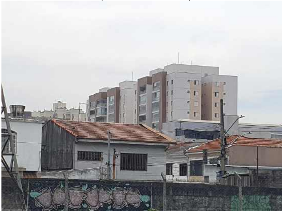
Foto 27: Vista da vizinhança, incluindo verticalização da Rua Marcelo de Menezes.
