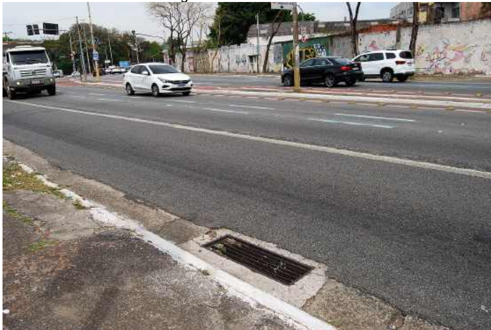
Foto 29: Sistema de drenagem existente na frente do terreno.
