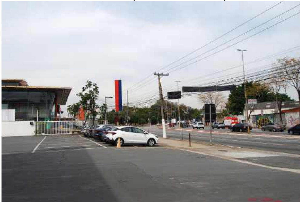
Foto 13: Avenida Zachi Narchi a partir do terreno do empreendimento.
