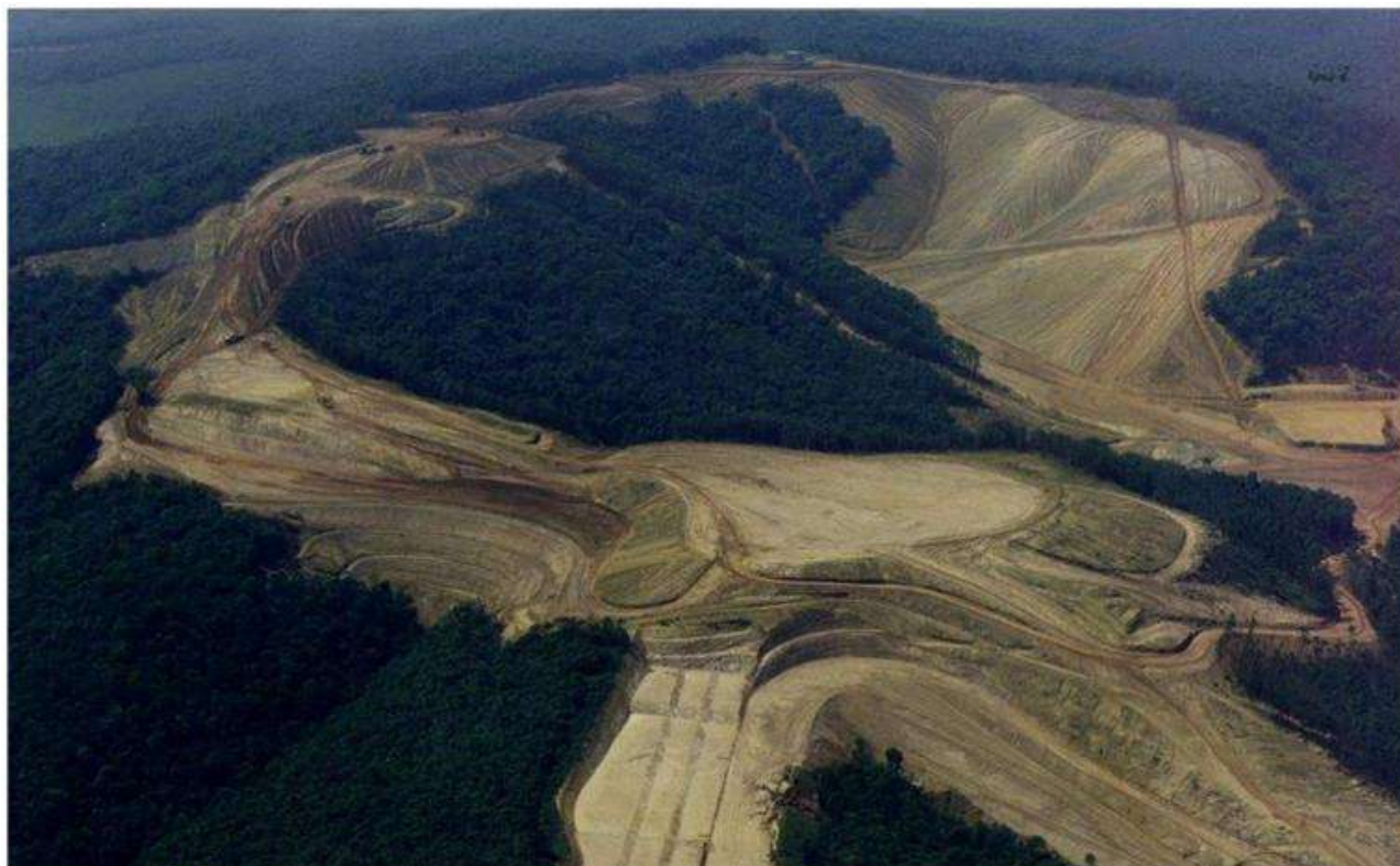
Foto 2 - Obras de Terraplenagem em Cidade Tiradentes - SP.
