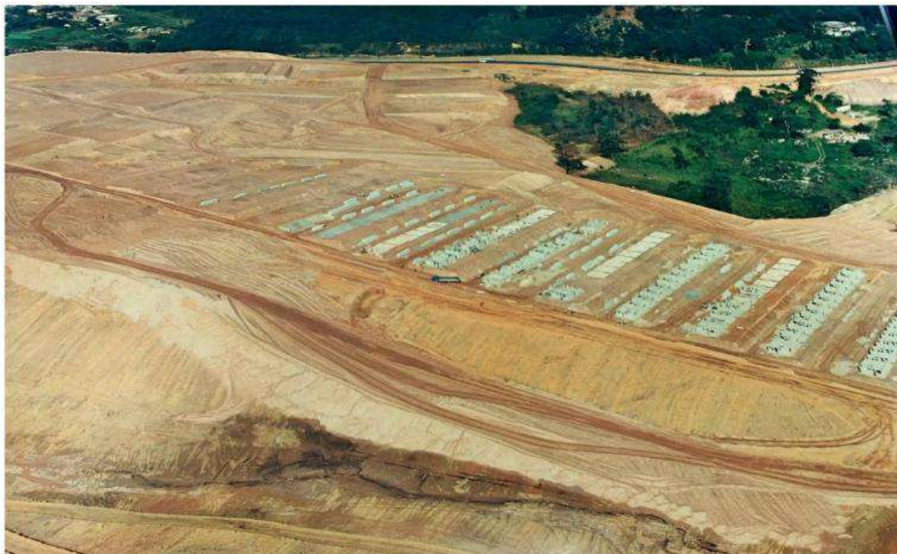
Foto 3 - Início das obras do Conjunto Santa Etelvina em 1989 - Cidade Tiradentes - SP.
