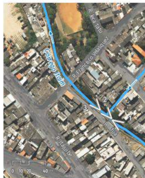
FIGURA 2.15 Fotos da região média do córrego Itaim, nas imediações da travessia da R. Francisco Velasquez
