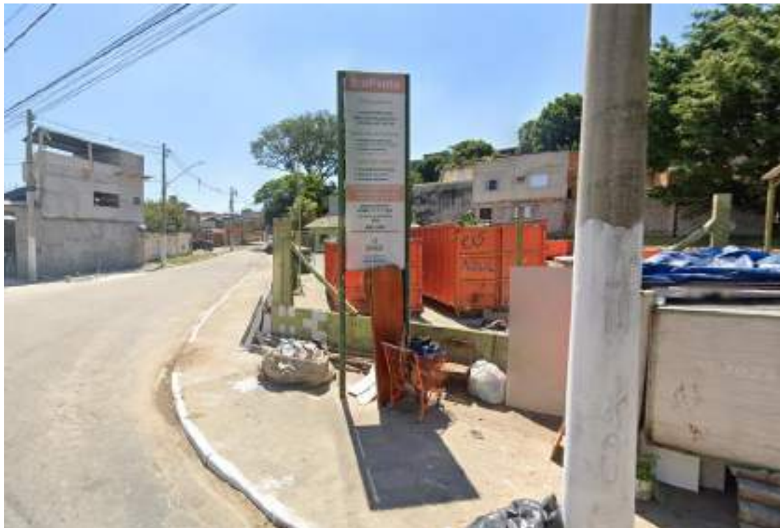
Foto 16 - Vista da fachada do Ecoponto Pesqueiro. Fonte: Google Maps, 2024.
