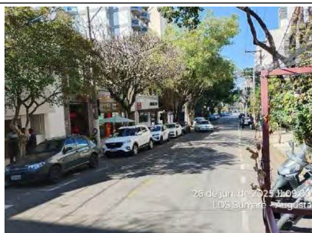
Foto 10: Vista geral da área do traçado na rua Lisboa, altura do número 548. Visada em sentido norte-sul. Área com residências, comércios e com alguns indivíduos arbóreos cadastrados na calçada.
