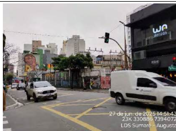
Foto 48: Vista geral da área do traçado na rua Augusta, altura do número 1221. Visada em sentido sul-norte. Final da LDS, na Estação Transformadora de Distribuição (ETD) Augusta.
