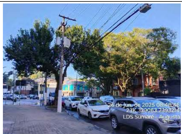
Foto 18: Vista geral da área do traçado na rua Estados Unidos, altura do número 2280. Visada em sentido norte-sul. Área com residências, comércios e com alguns indivíduos arbóreos cadastrados na calçada.
