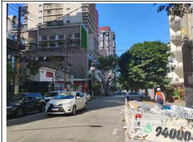
Foto 15: Vista geral da área do traçado na rua Cristiano Viana, altura do número 180. Visada em sentido norte-sul. Área com residências, comércios e com alguns indivíduos arbóreos cadastrados na calçada.
