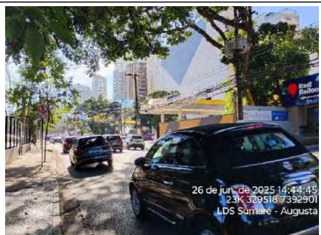
Foto 22: Vista geral da área do traçado na rua Estados Unidos, altura do número 1725. Visada em sentido sul-norte. Área com residências, comércios e com alguns indivíduos arbóreos cadastrados na calçada.
