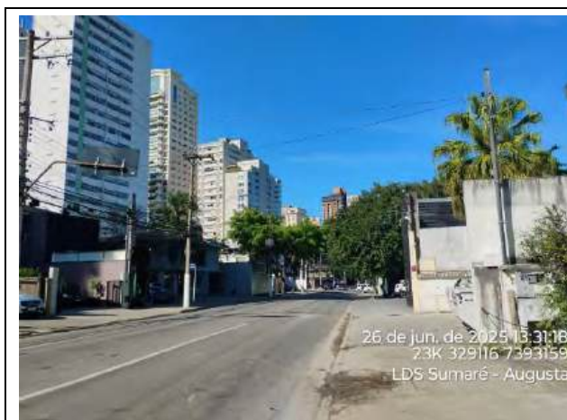
Foto 19: Vista geral da área do traçado na rua Estados Unidos, altura do número 2205. Visada em sentido norte-sul. Área com residências, comércios e com alguns indivíduos arbóreos cadastrados na calçada.
