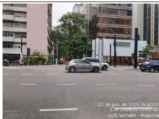
Foto 36: Vista geral da área do traçado no cruzamento da rua Haddock Lobo e da avenida Paulista. Visada em sentido sul-norte. Área com residências, comércios e com alguns indivíduos arbóreos cadastrados na calçada.
