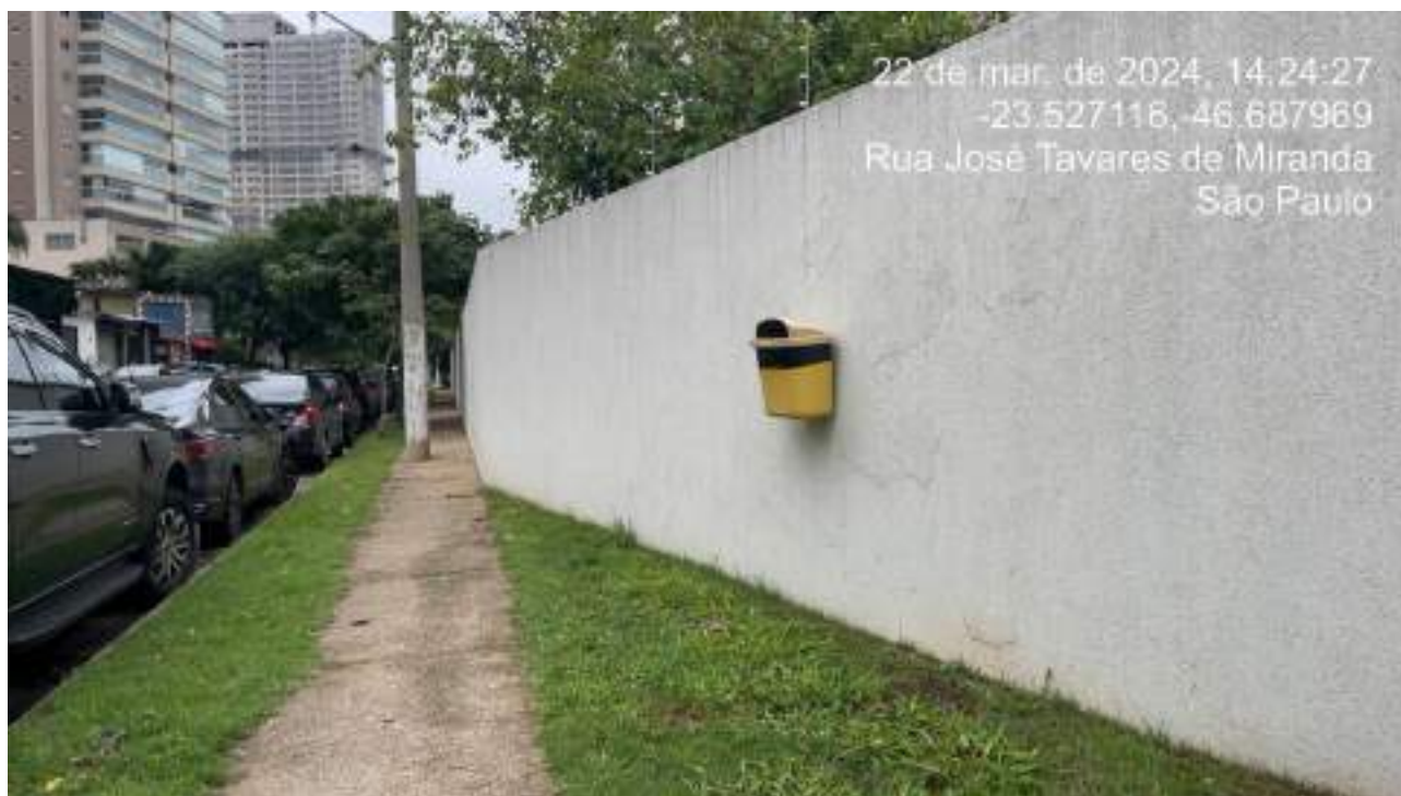
Figura 113 - Calçada na Rua José Tavares de Miranda, nas proximidades da ADA, sem descarte irregular de lixo e com
