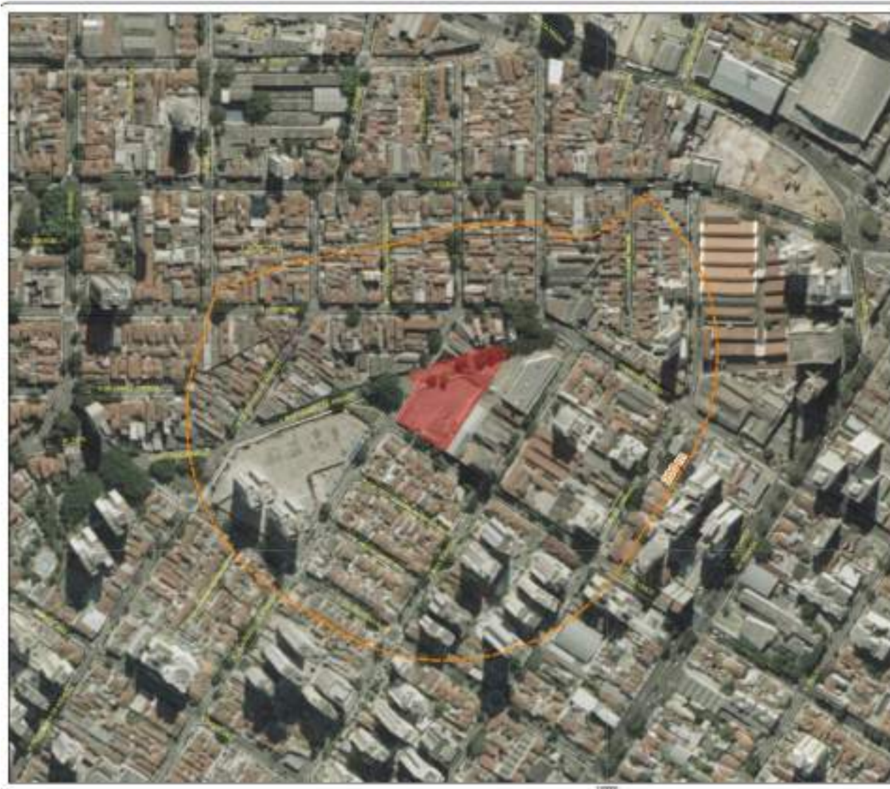
Figura 16 - Ortofoto de 2007 mostrando a Área de Influência Direta (AID) do 'Reservatório de Amortecimento - Córrego Água Preta'
