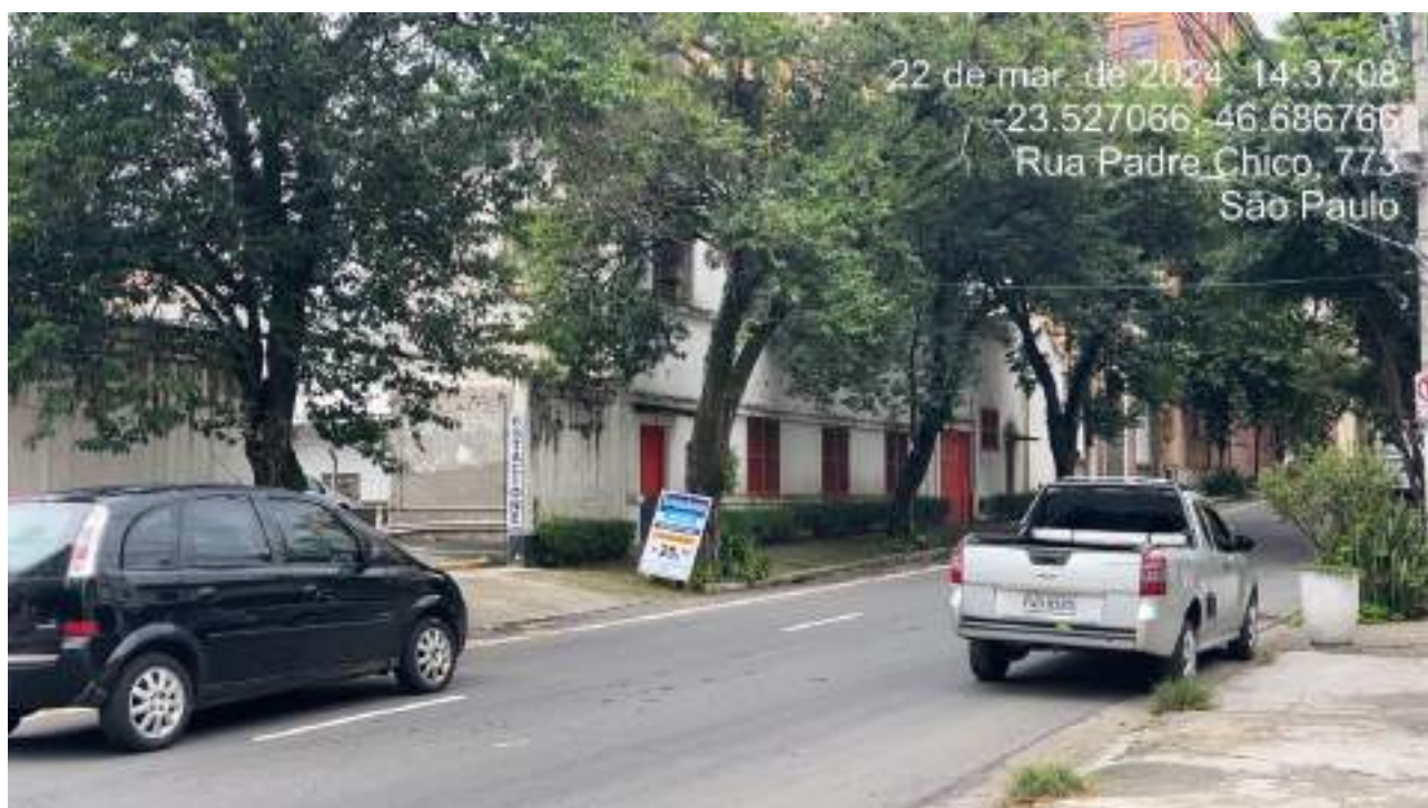
Figura 143 - Vista da entrada de Estacionamento Particular na ADA do empreendimento.
