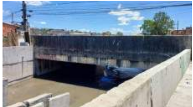
Foto 25 - Trecho já canalizado do Córrego Lajeado na região do empreendimento
