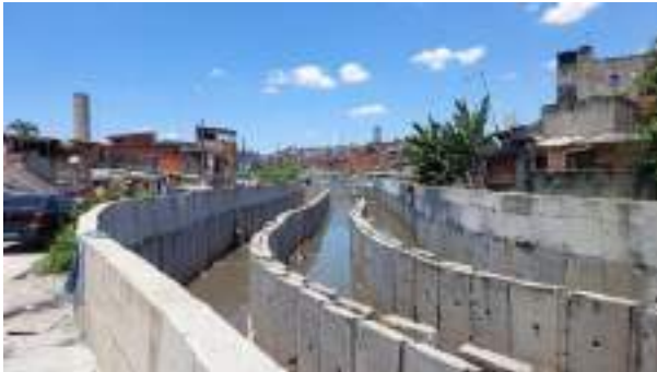
Foto 24 - Trecho já canalizado do Córrego Lajeado na região do empreendimento
