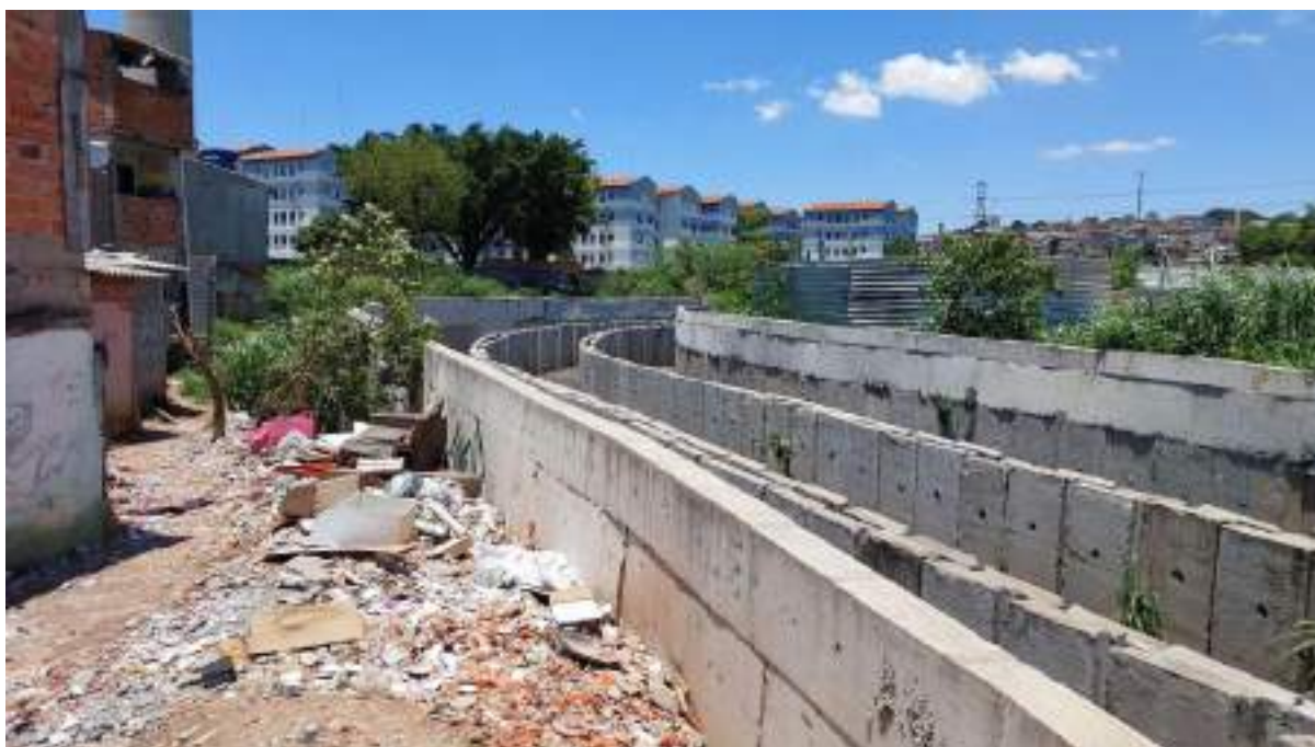
Foto 40 - Deposição de resíduos próximo ao córrego em trecho já canalizado de forma emergencial. Fonte: Centro Ambiental, 2024.
