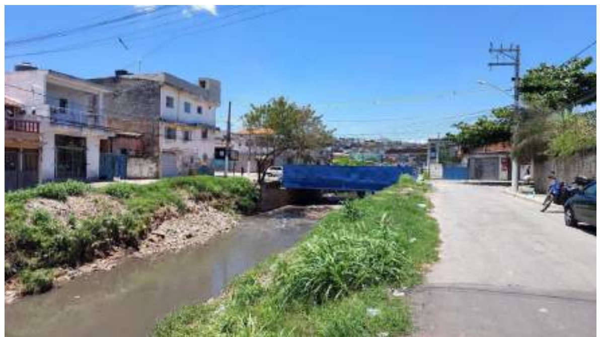
Foto 45 - Vista do córrego Lajeado em trecho a sofrer intervenções. Fonte: Centro Ambiental, 2024.
