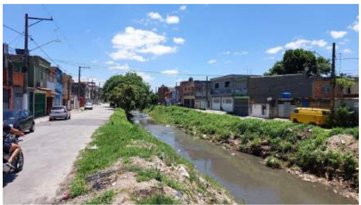
Foto 44 - Vista do córrego Lajeado em trecho a sofrer intervenções. Fonte: Centro Ambiental, 2024.
