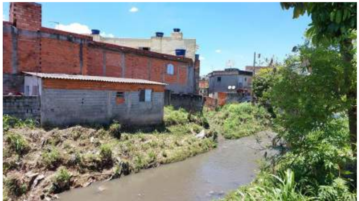
Foto 47 - Vista do córrego Lajeado em trecho a sofrer intervenções. Fonte: Centro Ambiental, 2024.
