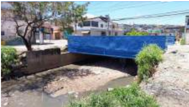
Foto 27 - Trecho Córrego Lajeado, objeto do Cadastramento Arbóreo
