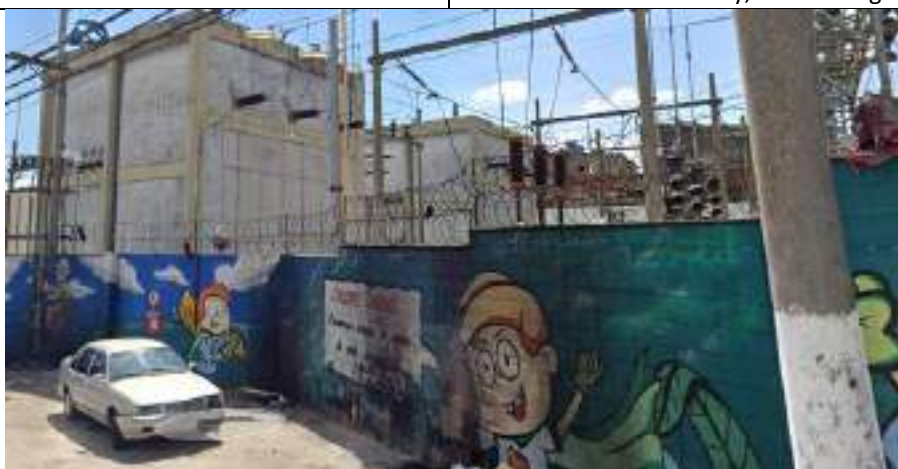
Foto 23 - AP-09 - Estação Transformadora de Energia EDT.
