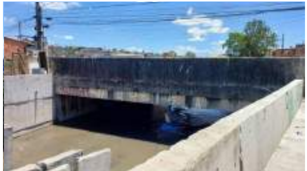
Foto 26 - Trecho já canalizado do Córrego Lajeado na região do empreendimento
