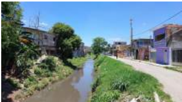
Foto 28 - Trecho Córrego Lajeado, objeto do Cadastramento Arbóreo
