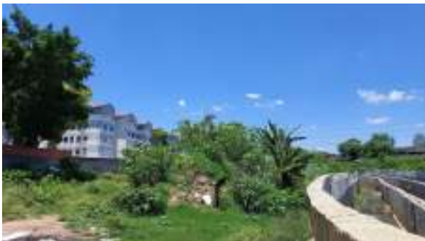
Foto 34 - Trecho já canalizado do Córrego Lajeado na região do empreendimento
