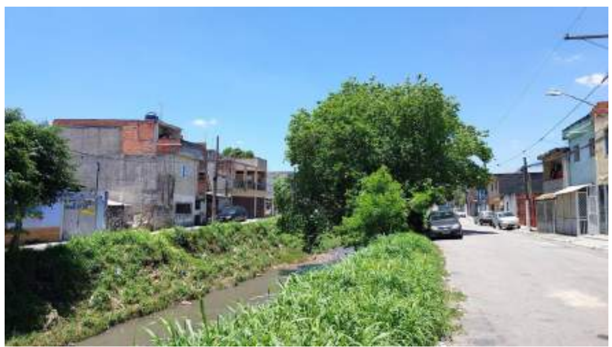
Foto 46 - Vista do córrego Lajeado em trecho a sofrer intervenções. Fonte: Centro Ambiental, 2024.
