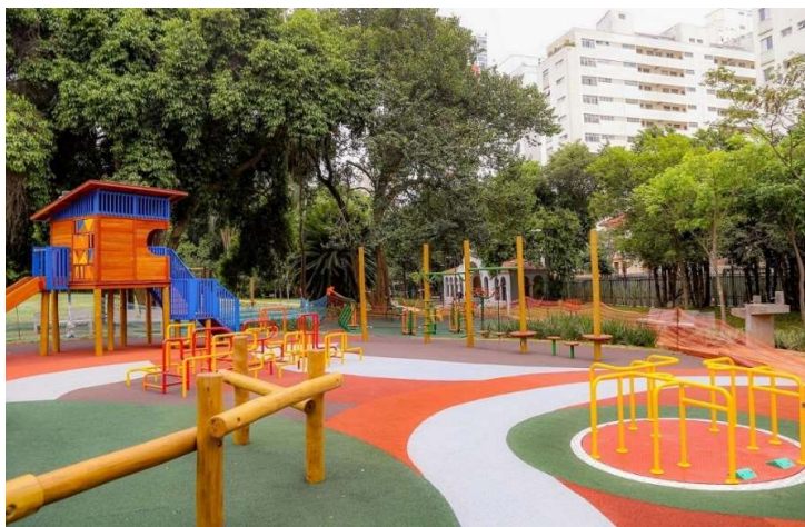
Figura 22– Visão geral do parquinho infantil e detalhe de estado de conservação
