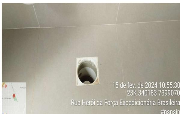
**Figura 117 Ralo recolocado no banheiro PCD (depois)**
