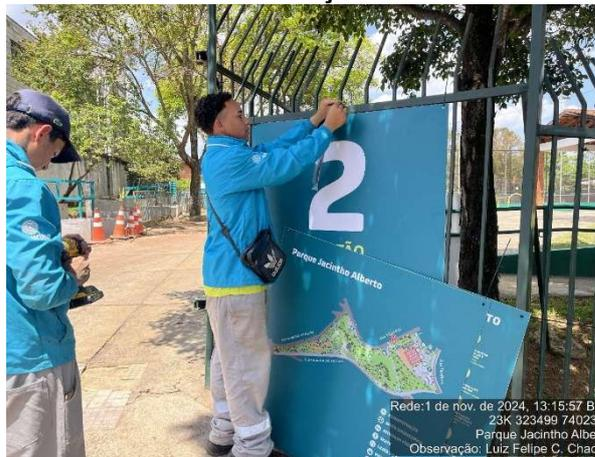
**Figura 127 Fixação de placas de sinalização**
