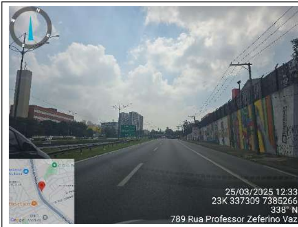
Foto 3.1.9. | Marginal da SP-150 - Via Anchieta. A imagem mostra o trecho da via após a via de acesso ao empreendimento.
