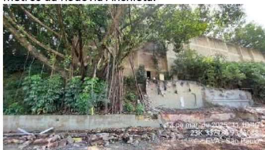
Figura 291- US11 - Muro de contenção visual.
