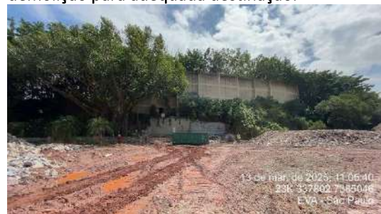
Figura 286- US09 - Muro instalado como barreira visual, destacando-se sua altura e elevada cota de implantação.
