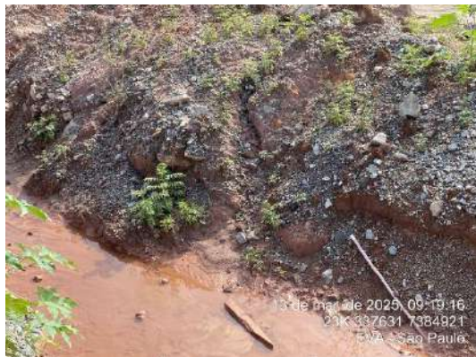
Figura 236- H03 - Drenagem escavada no terreno
