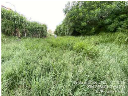
Figura 184- HAlI12 Córrego mapeado em base oficial, atualmente caracterizado por canal de drenagem seco para úmido
