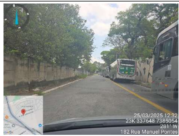
Foto 3.1.8. | Rua Professor Zeferino Vaz, sentido via Anchieta. Nota-se, pela imagem, a ausência de elementos de sinalização horizontal na via.
