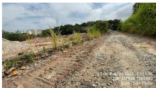
Figura 116- GEM 11 - Destaque ao declive no acesso.
