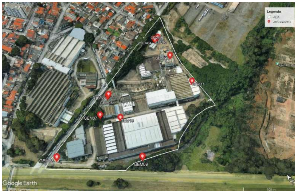
Figura 85- Distribuição espacial dos pontos onde foram encontradas as feições descritas na ADA, em imagem de satélite (Goole Earth, 2025).
