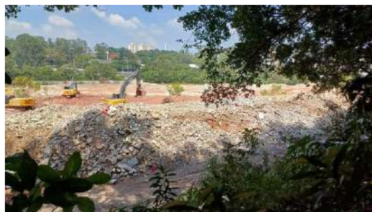
Figura 150- PED06 [-23.636732, 46.590472] – Maquinário operando na demolição do edifício e limpeza do terreno.
