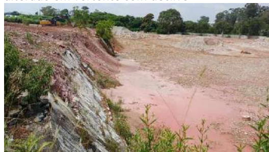
Figura 95- GEM05 – Talude antrópico, resultante de corte e aterro.
