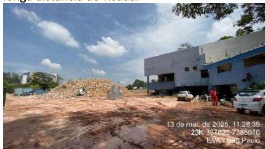
Figura 277- Edificações que ainda serão demolidas.
