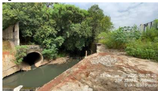
Figura 40– Canalização a céu aberto do Córrego Jaboticabal na AID.
