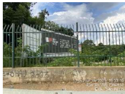
Figura 38 – Obras do Piscinão Jaboticabal na AID.
