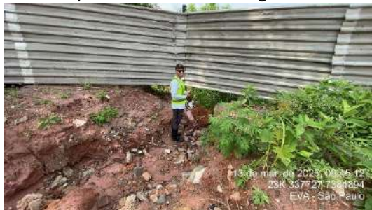
Figura 222- H08 - Saída de canaleta de drenagem escavada para o escoamento de água
