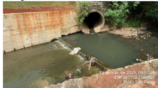
Figura 223- H09 - Tubulação de água pluvial sendo lançada no Córrego Jaboticabal
