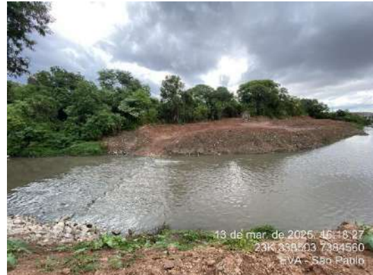
Figura 159- HAI01 - Confluência Córrego Ribeirão dos Meninos e Córrego Ourives com faixa de passagem de veículos
