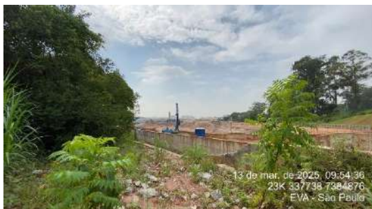
Figura 37- Obras do Piscinão Jaboticabal na AID.
