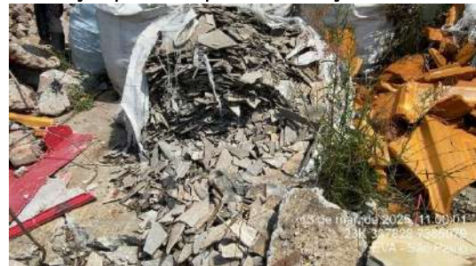
Figura 284- US08 - Segregação de resíduos da demolição para adequada destinação.
