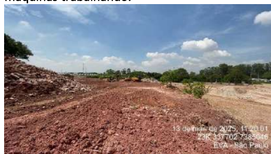
Figura 296- US15 - Situação atual da área em processo de demolição, com solo exposto e máquinas trabalhando.
