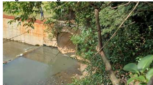
Figura 219- H07 - Canalização em seção aberta do Córrego Jaboticabal, com recebimento de contribuinte pluvial
