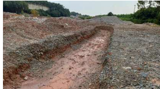
Figura 229- H11 - Drenagem provisória escavada no terreno
