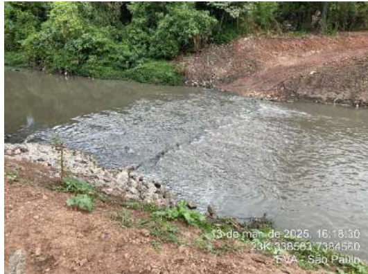
Figura 158- HAI01 – Córrego Ourives – Visível área de travessia de veículo
