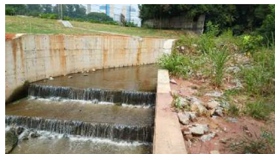
Figura 227- H10 - Infraestrutura de conexão do córrego ao piscinão em construção
