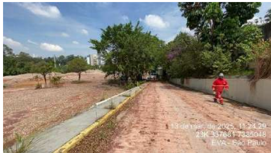
Figura 100- GEM06 - Detalhe da declividade área de acesso
