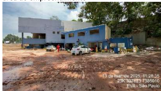
Figura 278- US05 - Edificações que ainda serão demolidas.
