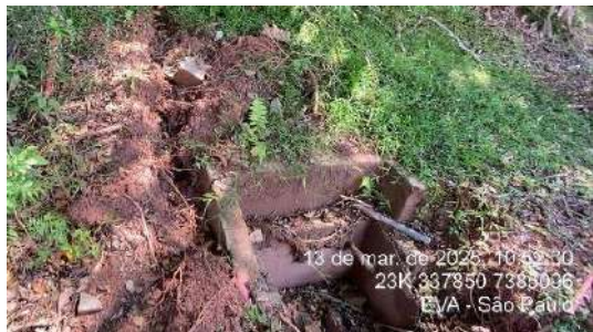
Figura 90- GEM02 – Corte exposto com vegetação rala e presença de erosão
