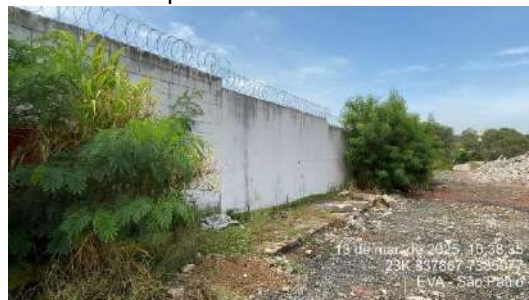
Figura 276- US04 – Muro limite nos fundos da área do empreendimento
