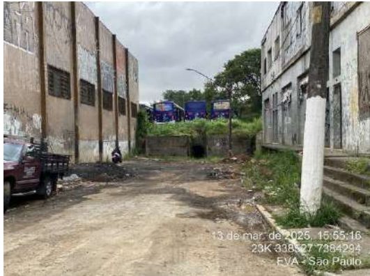
Figura 204- HC04 Captação de águas pluviais
