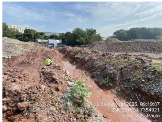
Figura 237- H03 - Drenagem escavada no terreno
