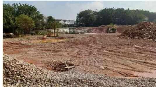
Figura 107- GEM 9 - Área com terraplenagem, solo exposto
