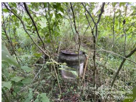
Figura 188- HAlI14 Tubulação de água pluvial
