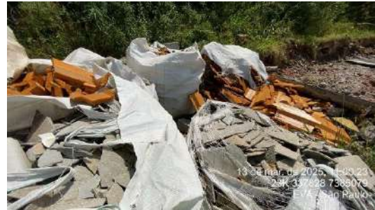
Figura 282- US08 - Segregação de resíduos da demolição para adequada destinação.
