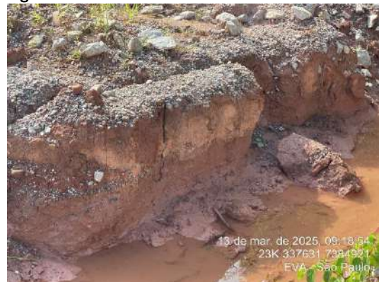
Figura 209- H03 - Exposição de litotipos devido à escavação provisória de rede de drenagem
