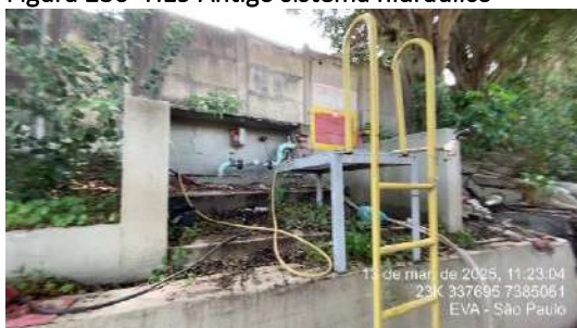
Figura 232- H19 Antigo sistema hidráulico
