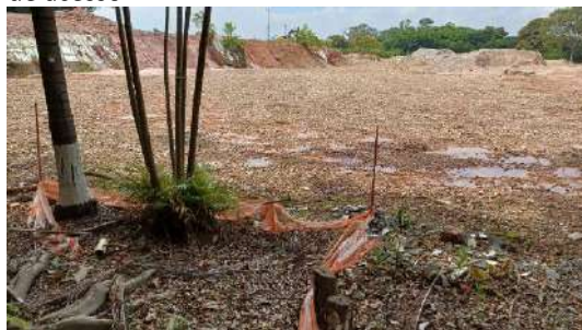
Figura 102- GEM7 - Área de terraplenagem.
