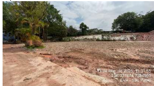
Figura 109- GEM 10 - Área com terraplenagem
