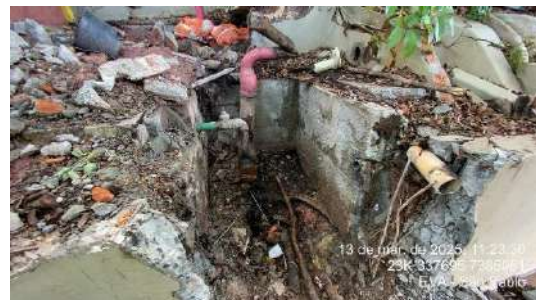
Figura 231- H19 Antigo sistema hidráulico
