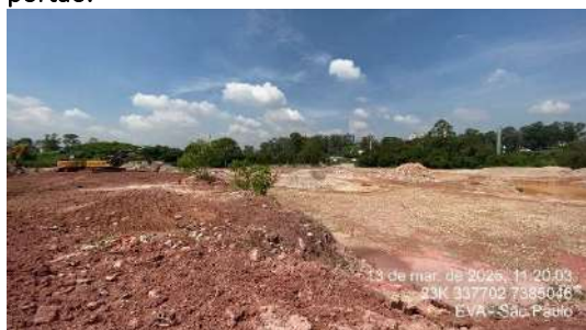
Figura 295- US15 - Situação atual da área em processo de demolição, com solo exposto e máquinas trabalhando.
