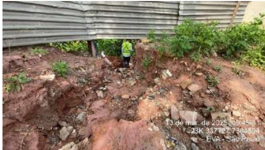
Figura 220- H08 - Saída de canaleta de drenagem escavada para o escoamento de água
