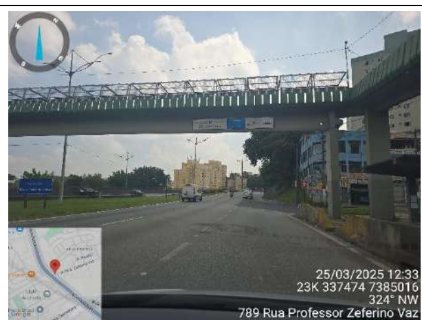
Foto 3.1.10. | Marginal da SP-150 – Via Anchieta. A imagem mostra a faixa de aceleração após a saída da Rua Prof. Zeferino Vaz, permitindo aos veículos que saem do empreendimento acessar a via sem maiores dificuldades.
