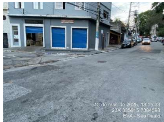
Figura 169– HAI06 Hidrografia constante em mapeamento oficial atualmente canalizada em área urbana
