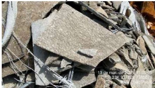
Figura 283- US08 - Segregação de resíduos da demolição para adequada destinação.
