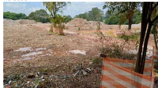
Figura 103- GEM 7 - Área de terraplenagem.
