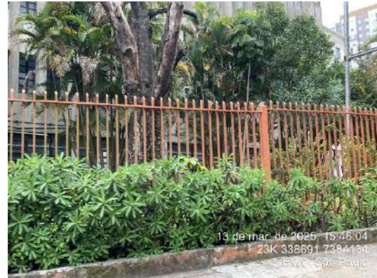
Figura 315- Fábrica, na área de entorno
