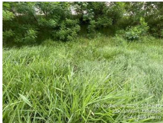
Figura 185- HAlI12 Córrego mapeado em base oficial, atualmente caracterizado por canal de drenagem seco para úmido
