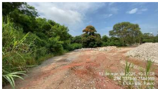
Figura 114- GEM 11 - Setor leste da ADA, porção mais baixa no entorno do Córrego Jaboticabal.
