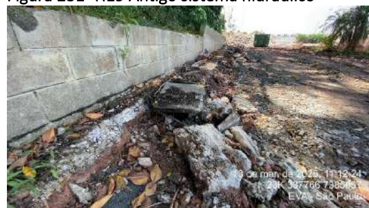
Figura 233- H19 Antigo sistema de drenagem, atualmente em demolição
