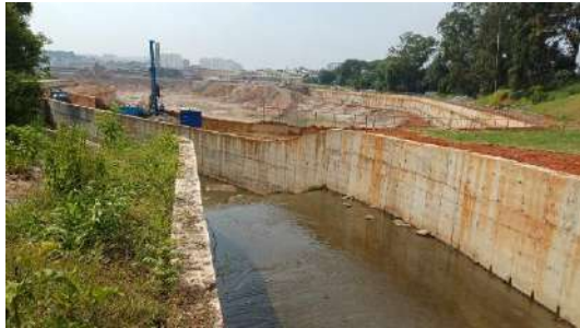
Figura 228- H10 - Conexão do córrego ao pisciñão em construção
