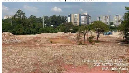
Figura 292- US12 - Situação atual da área em processo de demolição, com solo exposto e detritos em segregação.
