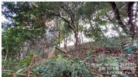
Figura 94- GEM04 - Muro alto em topo de terreno com desnível alto
