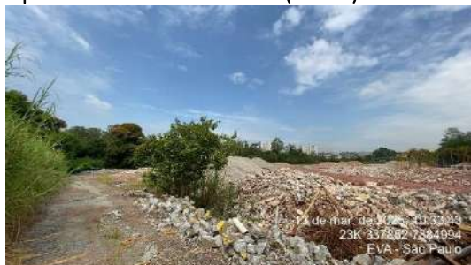
Figura 275- US03 – Área em demolição, notar longa distância de visada.
