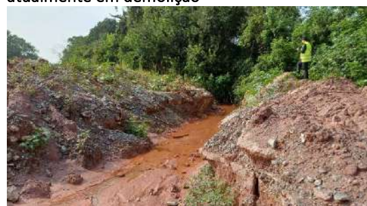
Figura 235- H02- Drenagem, escoamento para o Córrego Jaboticabal
