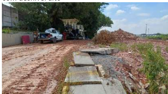
Figura 96- GEM05 – Área de movimentação de terra
