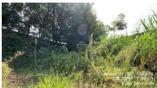
Figura 92- GEM03 - Desnível do terreno - Vista lateral do talude
