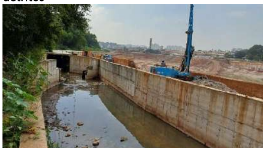
Figura 226- H10 - Infraestrutura de conexão do córrego ao piscinão em construção
