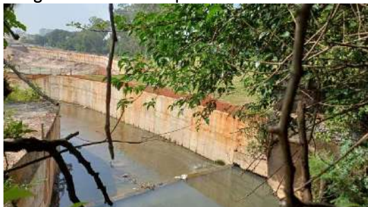
Figura 218- H07 - Canalização em seção aberta do Córrego Jaboticabal
