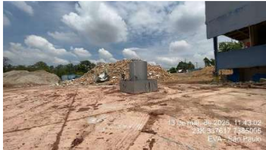
Figura 281- US07 - Tanque Provisório para uso nas obras de demolição
