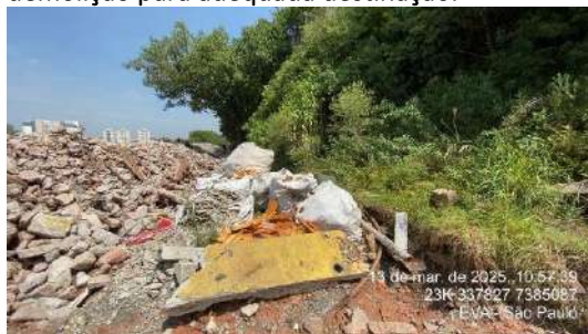
Figura 285- US08 - Segregação de resíduos da demolição para adequada destinação.
