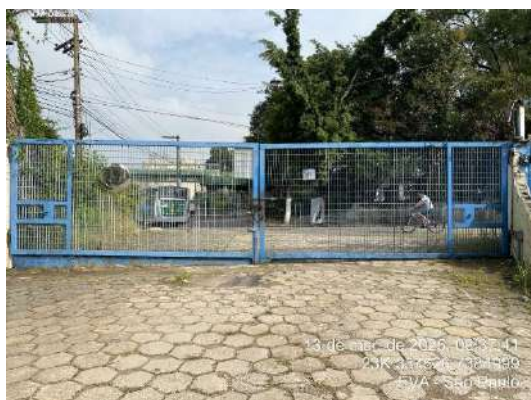
Figura 287- US10 - Acesso principal à ADA, a 15 metros da Rodovia Anchieta.
