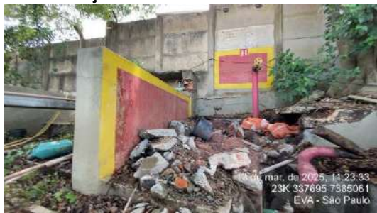
Figura 230- H19 Antigo sistema hidráulico
