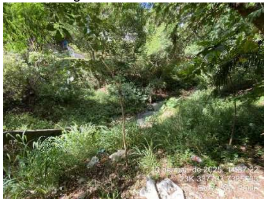
Figura 166- HAI04 – Resíduos plásticos e entulho na margem da drenagem (Córrego sem toponímia)
