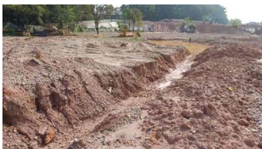
Figura 234- H01 - Drenagem escavada no terreno
