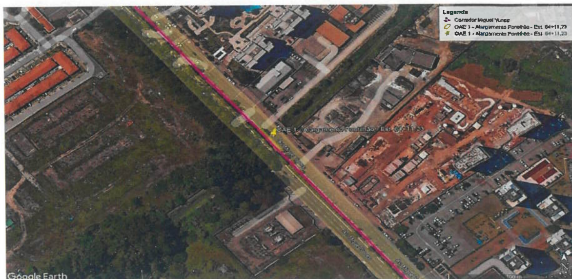
Figura 18 – OAE-1 - Ampliação de Tabuleiro (Google Earth)
