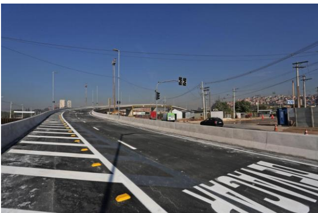
Viaduto do Sistema Viário Ponte Baixa
