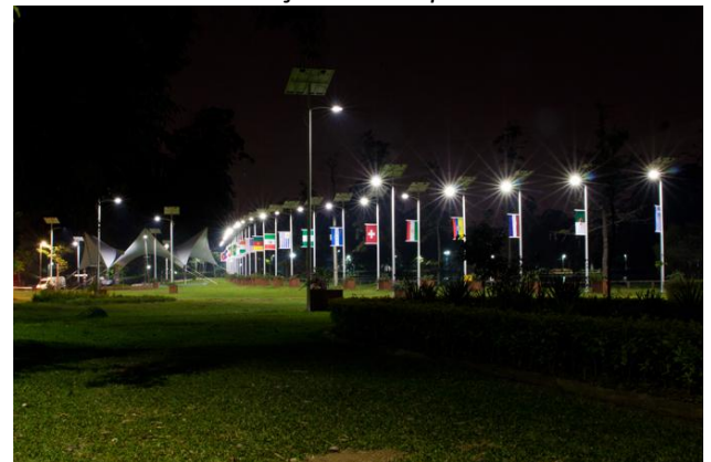
Nova iluminação do Parque do Carmo
