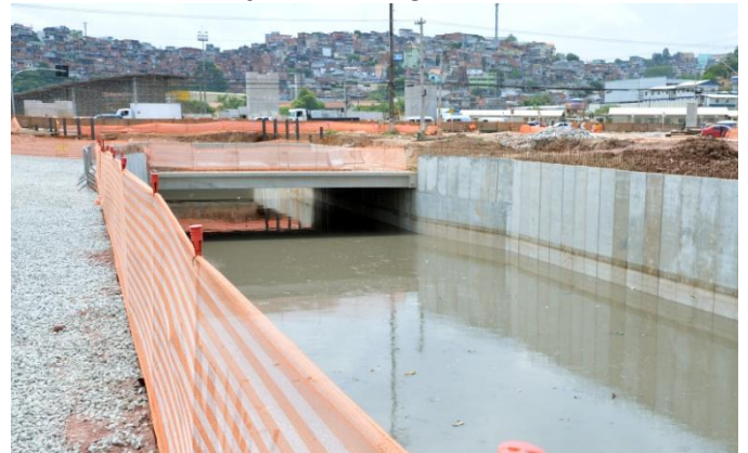
Canalização do Córrego Ponte Baixa
