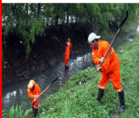
Limpeza de Córrego
