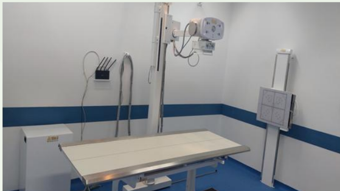
Sala de Raio-X – Reforma
