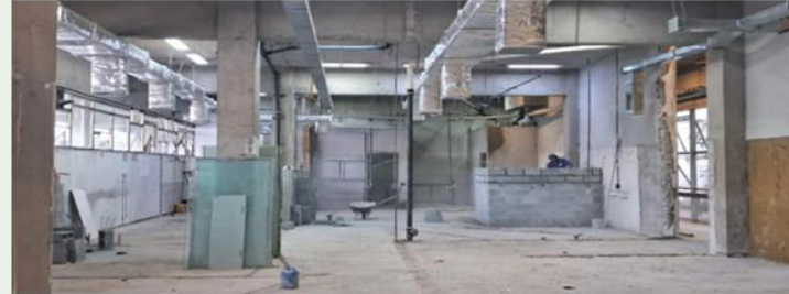
Pronto Socorro – Reforma em Andamento
