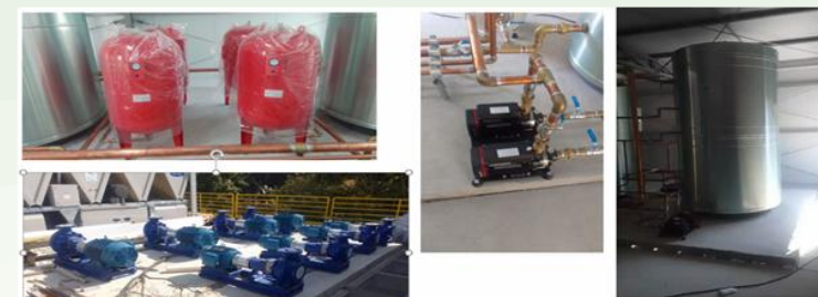
Start do sistema de aquecimento de água central no prédio anexo
