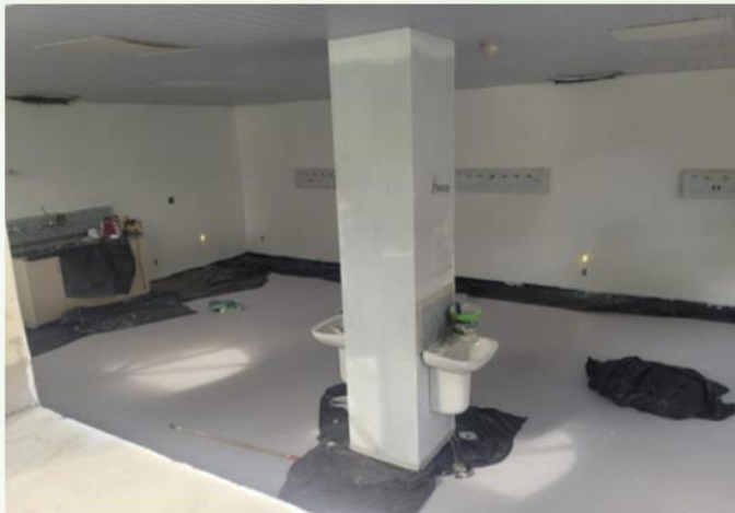
Ucinco (U5) – Reforço Estrutural
