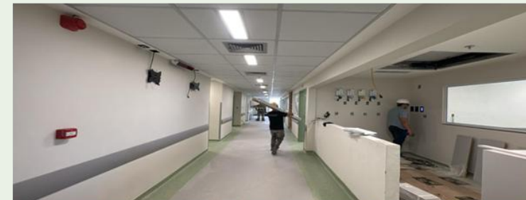
Centro de Tratamento de Queimados – Reforma em Conclusão
