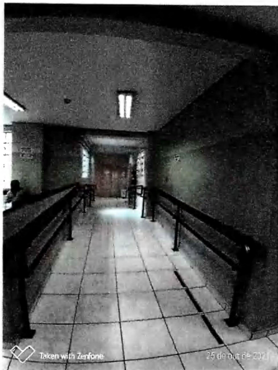
Figura 4-Foto 4 – Vista da rampa interna
