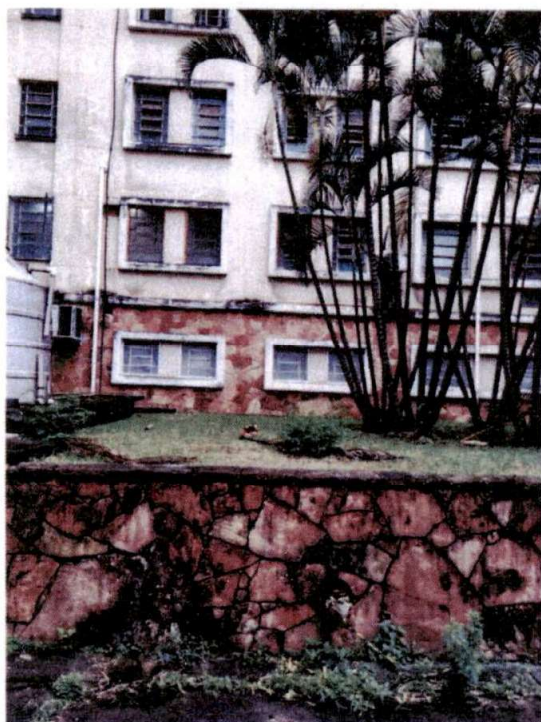
Foto 2 – Impermeabilização dos reservatórios, conforme memorial descritivo
