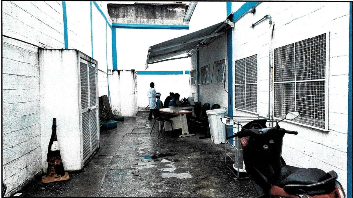
FOTO 1 – Lateral da unidade. Abrigo de oxigênio à esquerda e ao fundo, abrigo do compressor.
