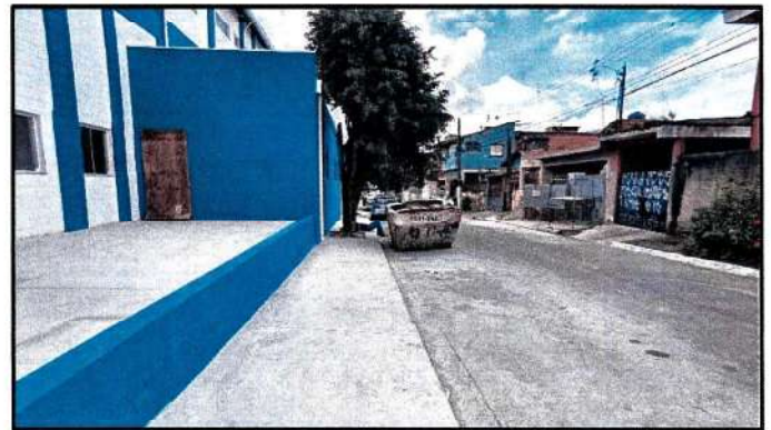
FOTO 4 – Detalhe entrada emergência
