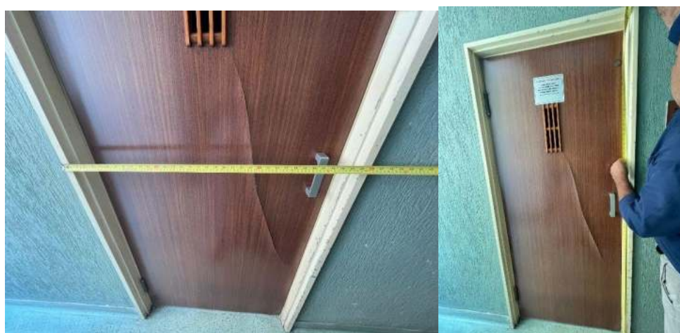
Figura 4 - Elevador de serviço - estreito
