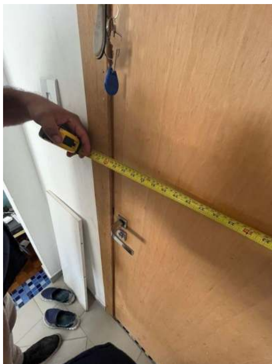
Figura 5- Porta 03 de acesso à residência - adequada
