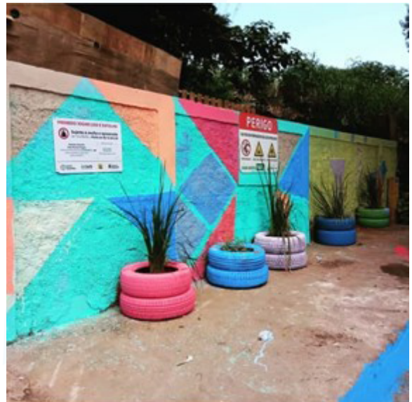
CRS Sul. STS M'Boi Mirim. UBS Vila das Belezas. Revitalização na Rua Vitalina Grassman. Depois.
