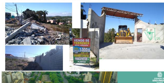
Rua Estrada do Porto – Jardim Marilda - Operação 15/08/2025
