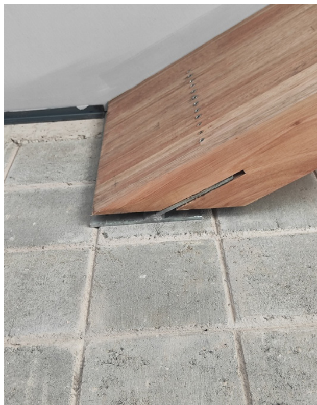
Figuras 31-32 - Painéis de MLC compondo o sistema estrutural do 1º piso e Ligações metálicas embutidas para ancoragem de elemento em MLC à base em concreto
