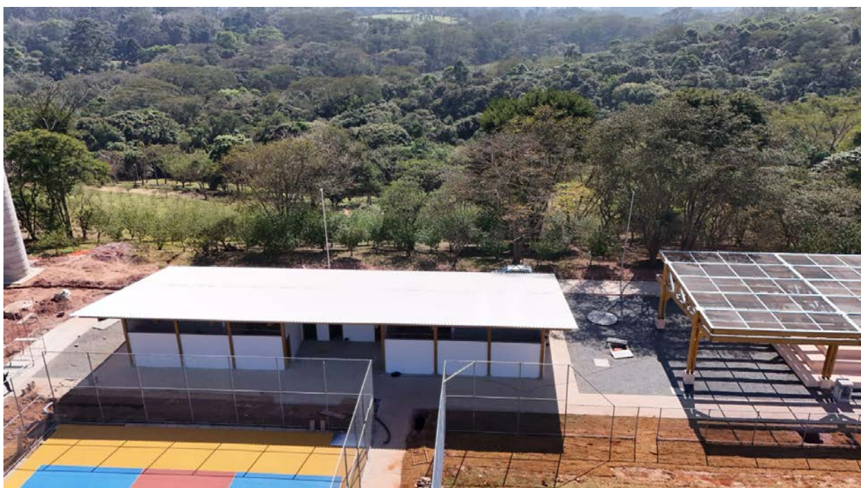
Figura 24 - Núcleo esportivo em obras: vestiários com a instalação de telhas termoacústicas.
