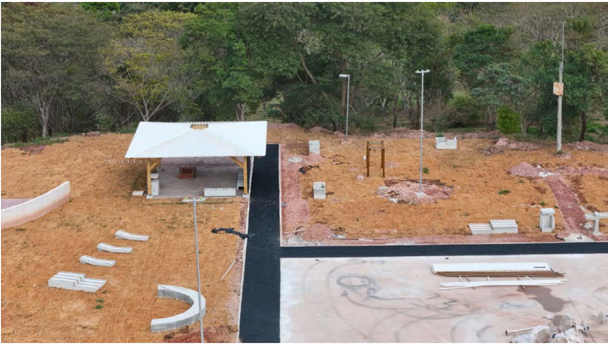
Figura 21 - Núcleo esportivo em obras: quiosques em MLC com telha termoacústica.
