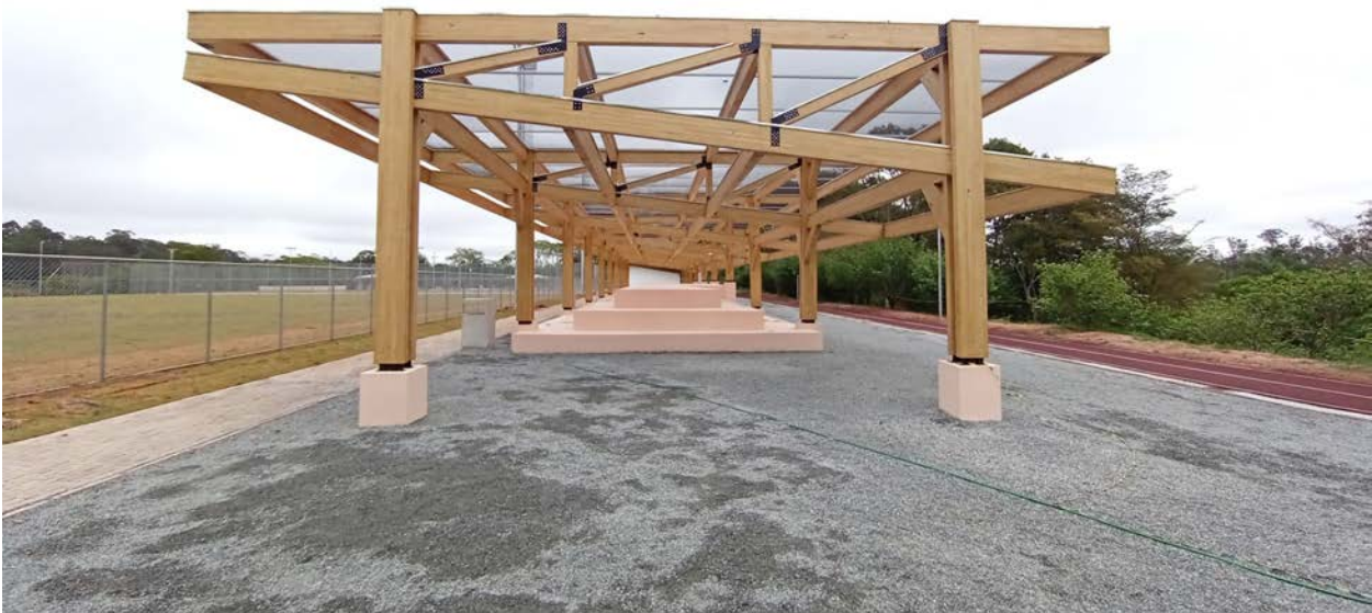
Figura 16 - Núcleo esportivo em obras: cobertura em MLC para a arquibancada.
