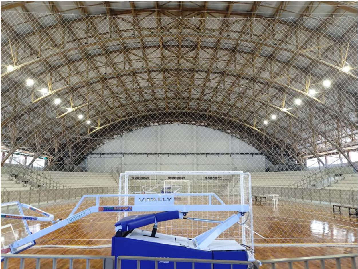
Figuras 40-41 - Ginásio Poliesportivo com sistema estrutural Hauff.
