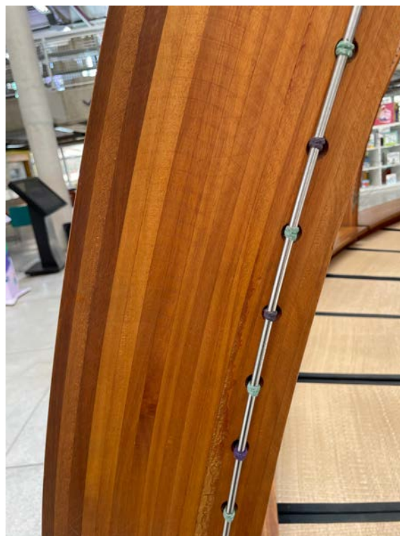
Figuras 26-27 - Elementos estruturais curvos em madeira laminada colada (MLC), com perfurações para passagem de cabos tensionados.
