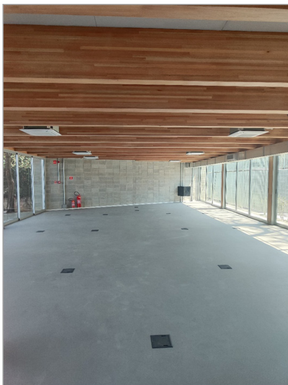
Figuras 31-32 - Painéis de MLC compondo o sistema estrutural do 1º piso e Ligações metálicas embutidas para ancoragem de elemento em MLC à base em concreto
