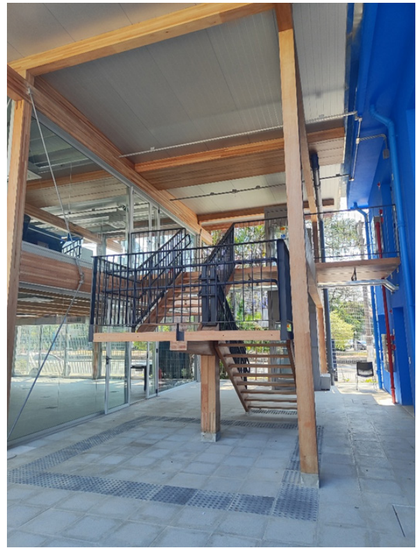
Figuras 33-34 - Chapas e conectores metálicos para união de peças em MLC e escada com piso e estrutura em MLC.
