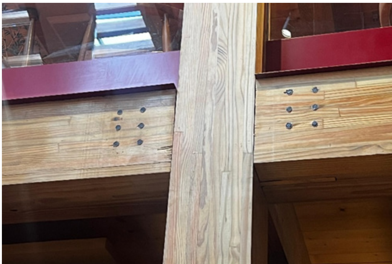
Figura 50 - Ligação entre vigas de madeira com elementos metálicos de fixação.
