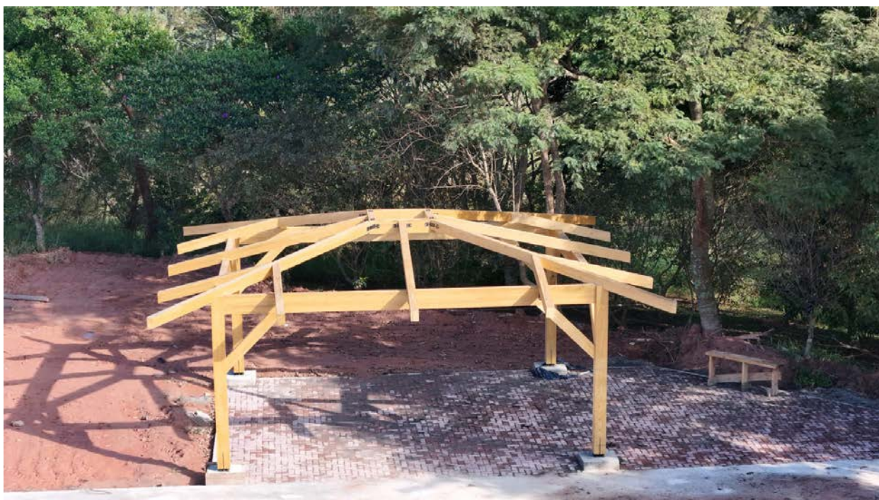
Figura 20 - Núcleo esportivo em obras: quiosques em MLC.
