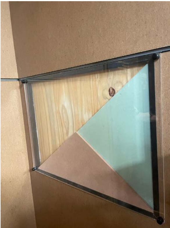
Figura 57 - Estrutura de madeira revestida com revestimento misto.
