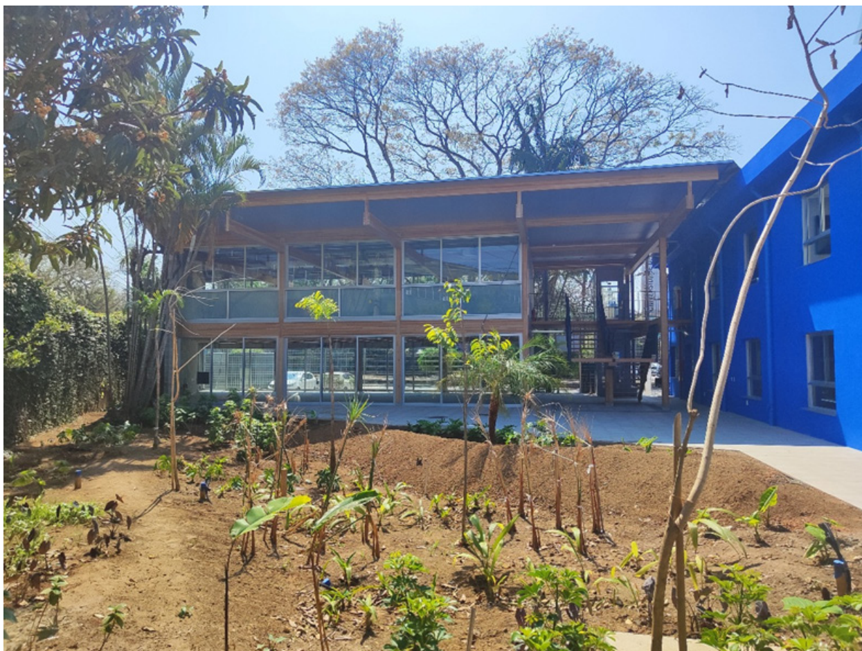
Figura 30 - Expansão do prédio de 2 andares da Fundação de Apoio à Universidade de São Paulo com estrutura em Madeira Lamelada Colada (MLC)
