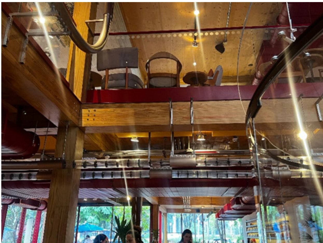
Figura 49 - Pilares, vigas e painéis de madeira no interior da Fábrica de Dengo.
