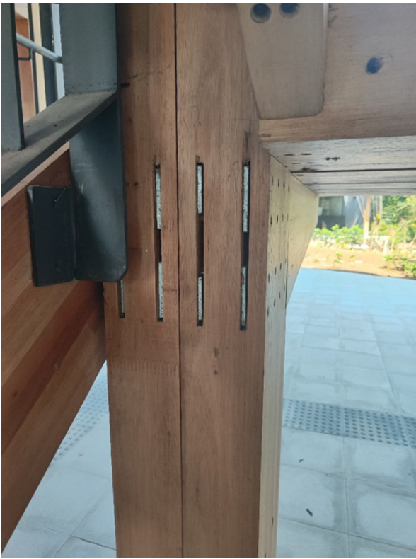
Figuras 33-34 - Chapas e conectores metálicos para união de peças em MLC e escada com piso e estrutura em MLC.
