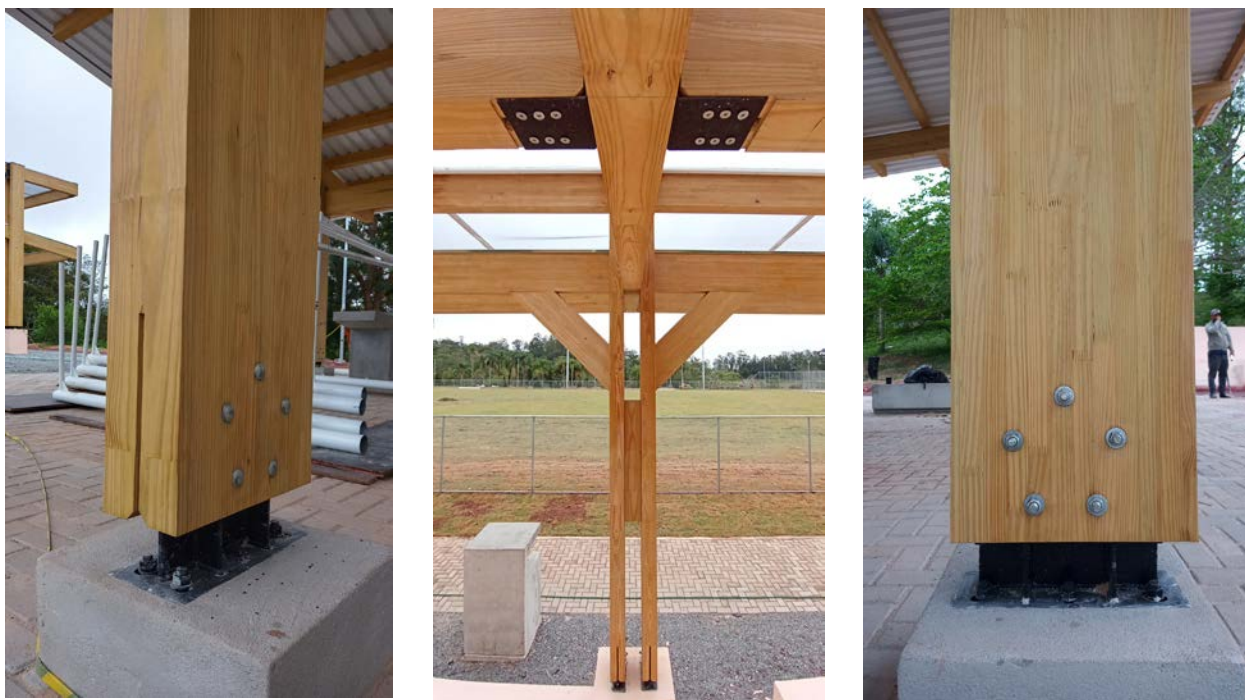
Figuras 17-19 - Núcleo esportivo em obras: detalhes dos pilares em MLC.
