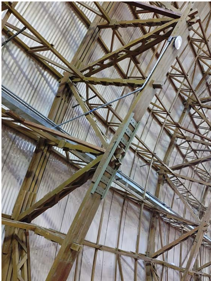
Figuras 38-39 - Elemento metálico de reforço estrutural para contenção de deslocamento vertical (Sistema Hauff)
