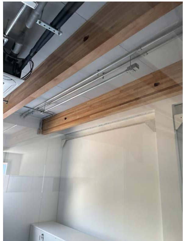
Figura 36 - Edifício existente em concreto com vigas em MLC adicionadas à estrutura
