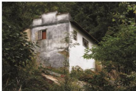
Casa do encarregado do Cloro. 08/2006.
