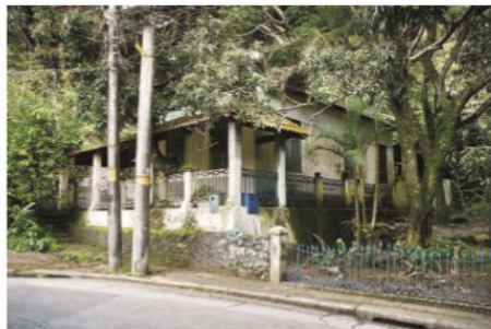
Casa do encarregado das Caixas. 08/2006.
