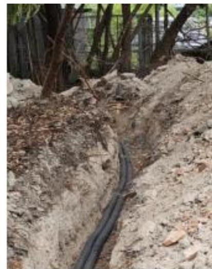
Passagem de eletrodutos.
