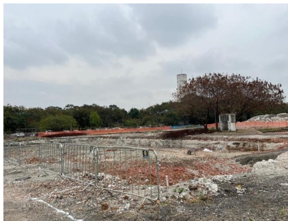
Bloco 6: Preparação da área para serviços de fundação
