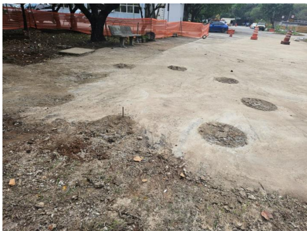
Concretagem da base da caixa d'água.
