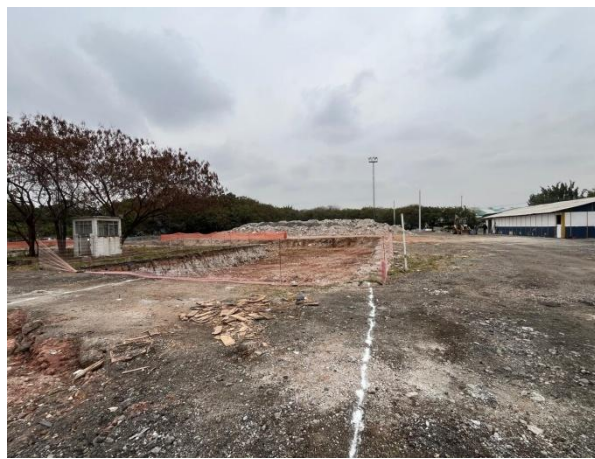
Unidade D: Demarcação e preparação da área para serviços de fundação.
