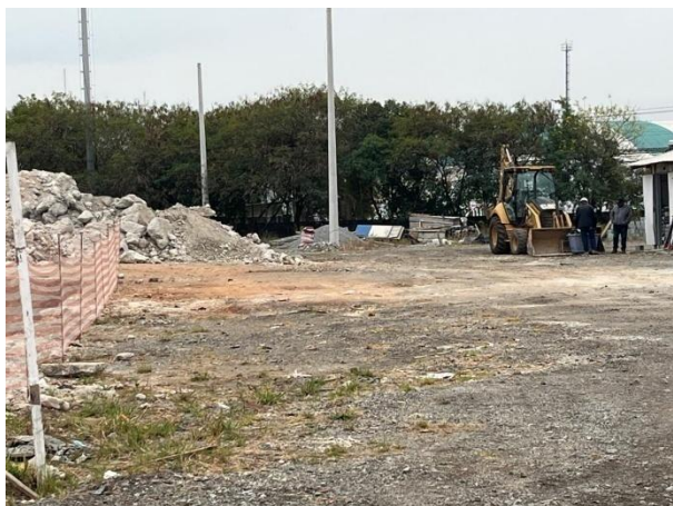
Vista geral da obra, entulho ao fundo.
