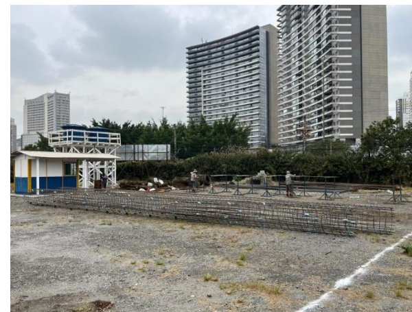
Armadura para fundação.
