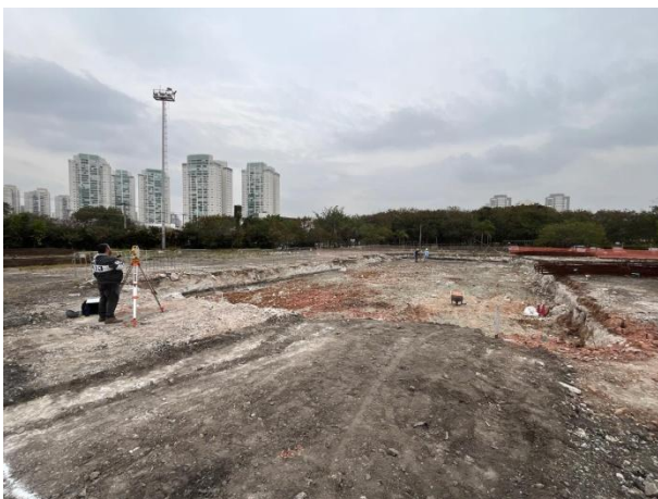
Bloco 3A: Serviço de topografia .
