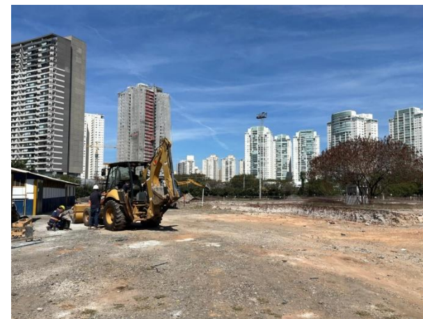
Vista da área de fundação do bloco Comercial.
