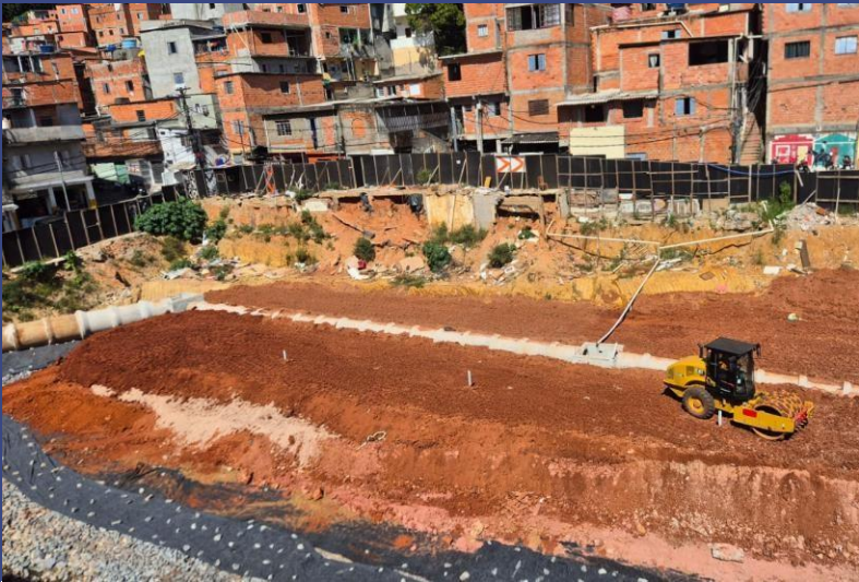
Execução da drenagem de 800mm do viário – Trecho 2
