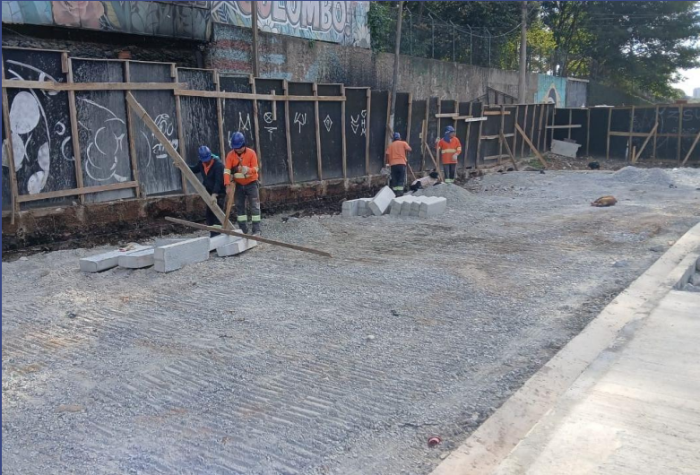
Preparação de terreno para colocação de guias – Trecho 1
