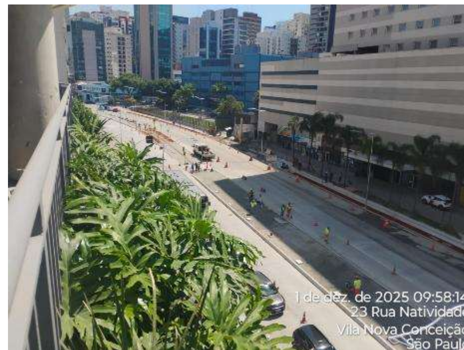
REQUALIFICAÇÃO TRECHO 2A
