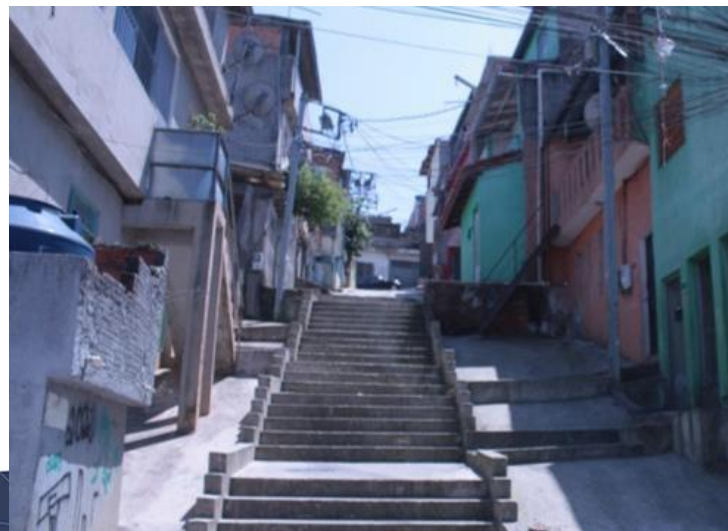
Favela Boulevard da Paz: Antes e Depois das Obras de Urbanização
