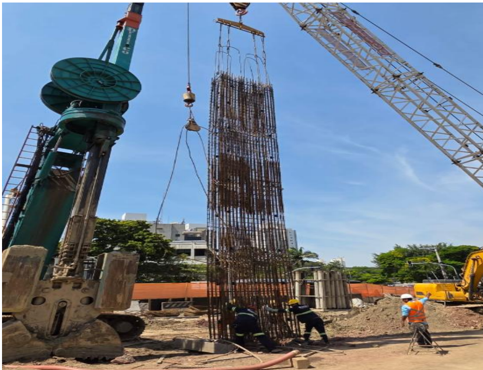
Íçamento e instalação de armadura metálica da Lamela S.0804
