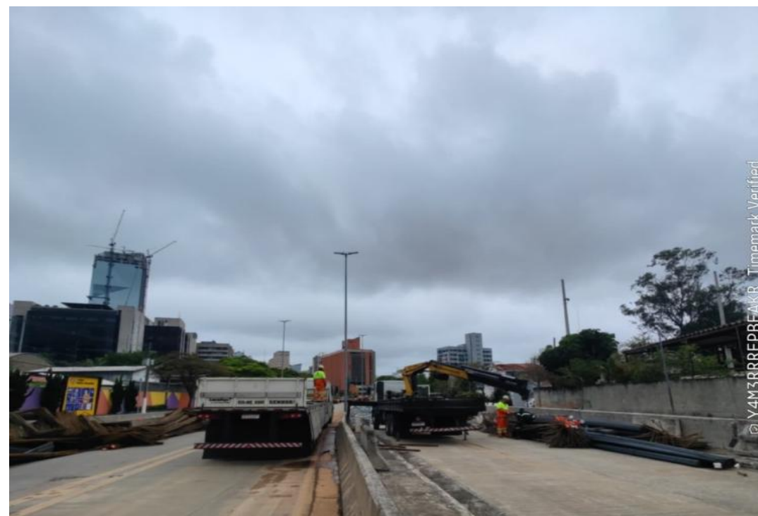
Descarga de aço para armação metálica da Lamela
