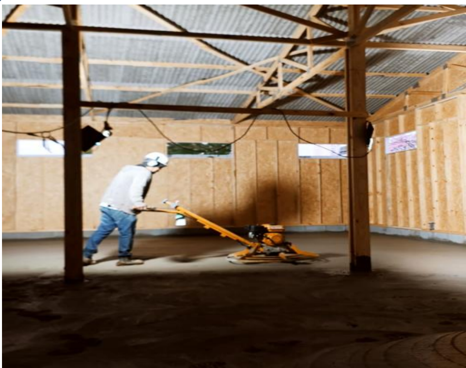
Alisamento do concreto com acabadora de piso para novo refeitório e vestiário
