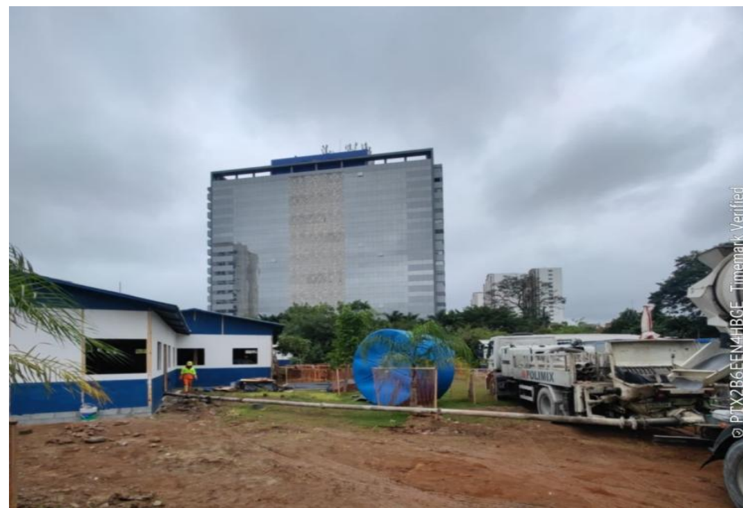
Concretagem com bombeamento para piso do refeitório e vestiário
