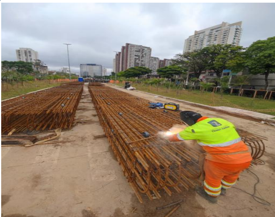
Montagem da armação metálica para a lamela
