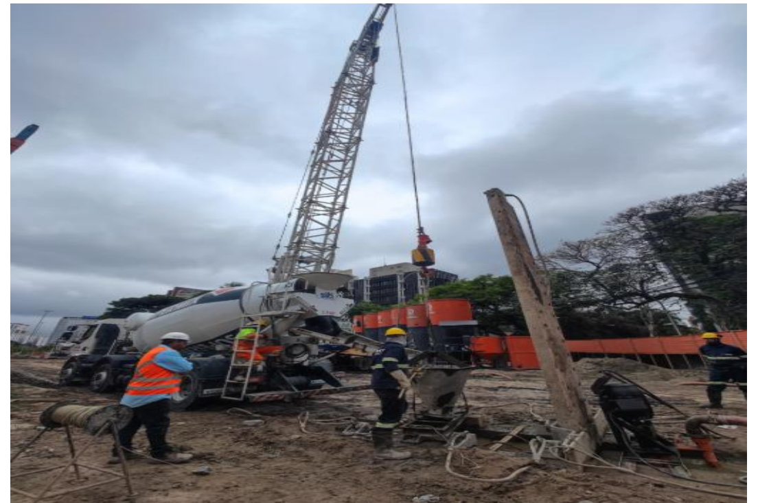
Concretagem da Lamela E.0821
